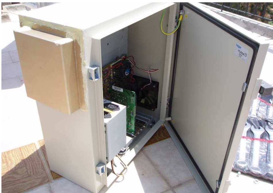
Η ιδιοκατασκευή έτοιμη λίγο πριν τοποθετηθεί στην ταρατσα.
