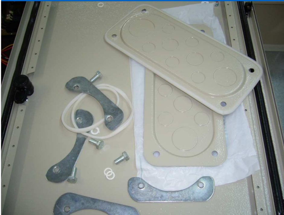
Προετοιμασία ηλεκτρολογικού κουτιού
