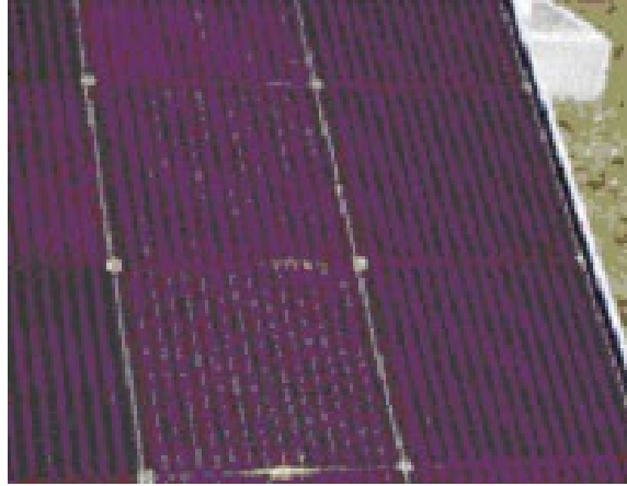
Εικόνα 2.4 Μορφή ΦΒ κυψελίδας άμορφου Πυριτίου
