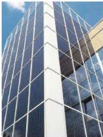
Εφαρμογή φωτοβολταϊκών σε πρόσοψη κτιρίου
