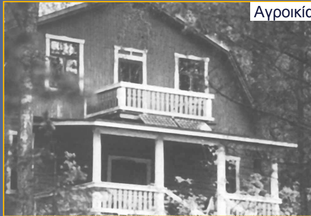
Αναφορά Φωτο: Fortum NAPS (Photovoltaics in Cold Climates)
