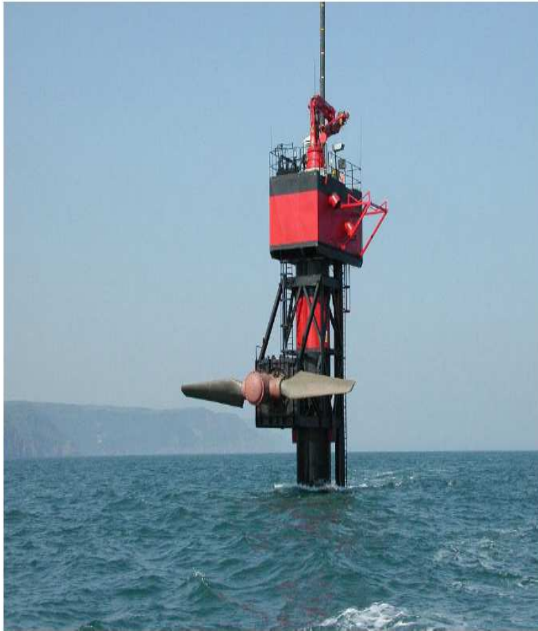
Seaflow: υπεράκτια εφαρμογή 300 KW (Βρετανία)
