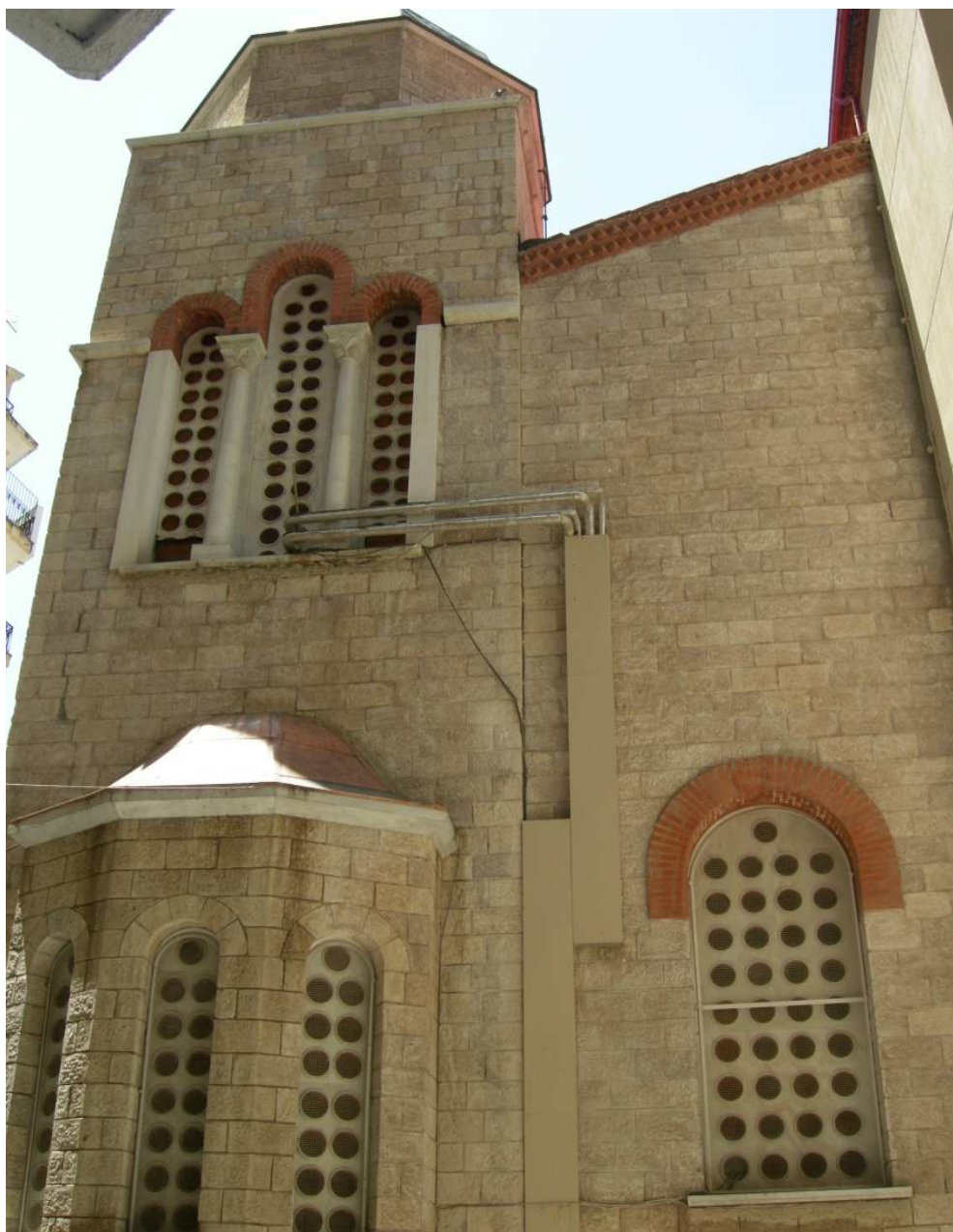
Πλάνο από την πίσω πλευρά της εκκλησίας
