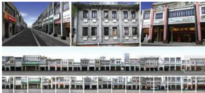
Εικόνα 16: Τεχνικής βασισμένης σε εικόνα (Image-based) πρόσοψης [ΧΙΑΟ J. et. al 2008]. Οι 3D προσόψεις ανακατασκευάστηκαν από εικόνες από πολλαπλά επίπεδα εδάφους και όψεις δρόμων. Οι εικόνες είναι ευγενική προσφορά του Tan Ping, Εθνικό Πανεπιστήμιο της Σιγκαπούρης, Σιγκαπούρη.
