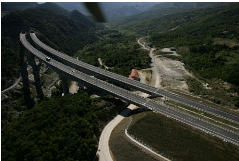
Εικόνα 2 : Χαραδρογέφυρα τομέα Ηπείρου.
