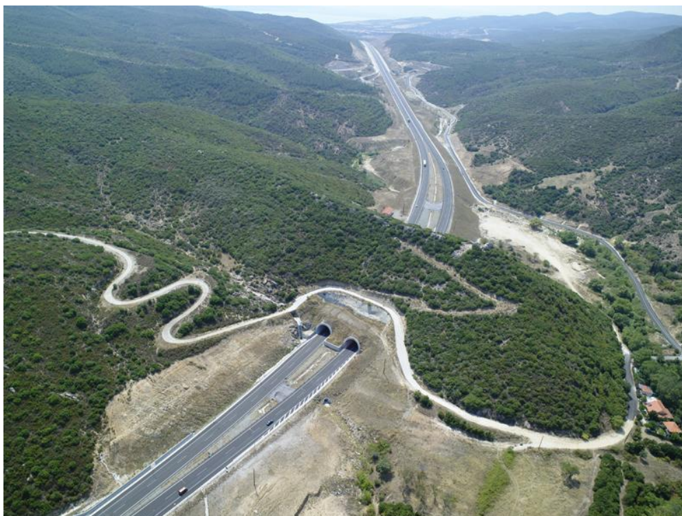
Εικόνα 7 : Δίδυμες Σήραγγες Εγνατίας Οδού τομέα Κεντρικής Μακεδονίας.
