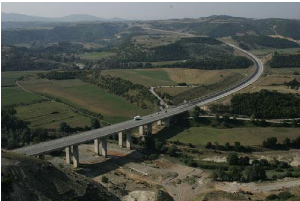
Εικόνα 4 : Κοιλαδογέφυρα τομέα Δυτ. Μακεδονίας.
