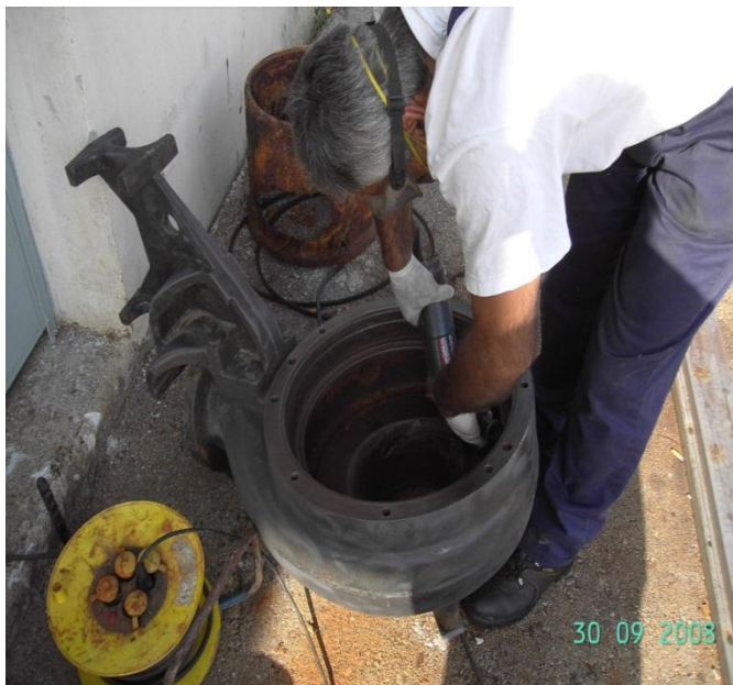
Σχ. 3.9.: Επισκευή αντλίας στο συνεργείο
