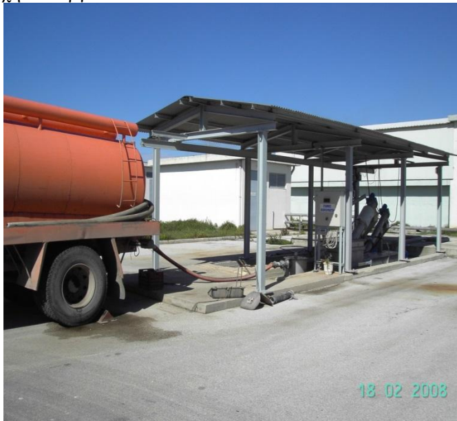
Σχ. 3.2.: Σταθμός βοθρολυμάτων
