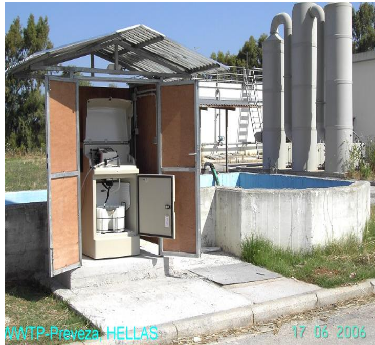
Σχ. 3.6.: Οικίσκος δειγματολήπτη εκροής
