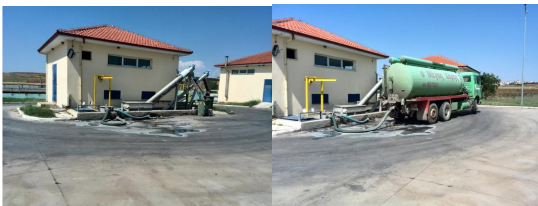
Σχ. 3.20.: Μονάδα υποδοχής και προεξεργασίας βοθρολυμάτων
