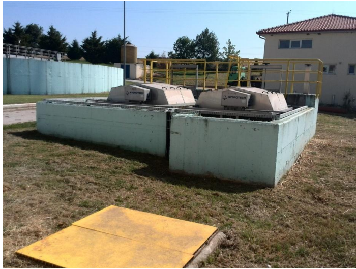
Σχ. 3.27.: Φίλτρα διύλισης – Μετρητής παροχής
