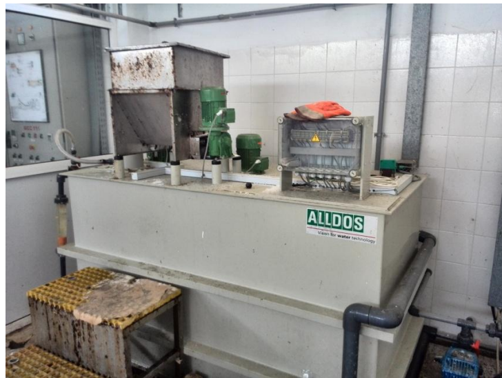
Σχ. 3.26.: Χημική κατακρήμνιση φωσφόρου
