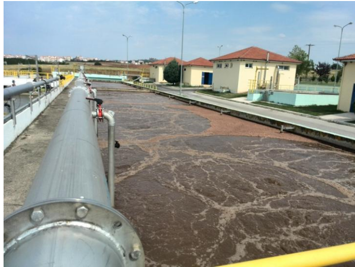
Σχ. 3.23.: Δεξαμενές απονιτροποίησης – Νιτροποίησης (Αερισμού)
