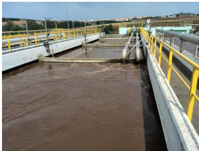
Σχ. 3.22.: Δεξαμενή βιολογικής απομάκρυνσης φωσφόρου
