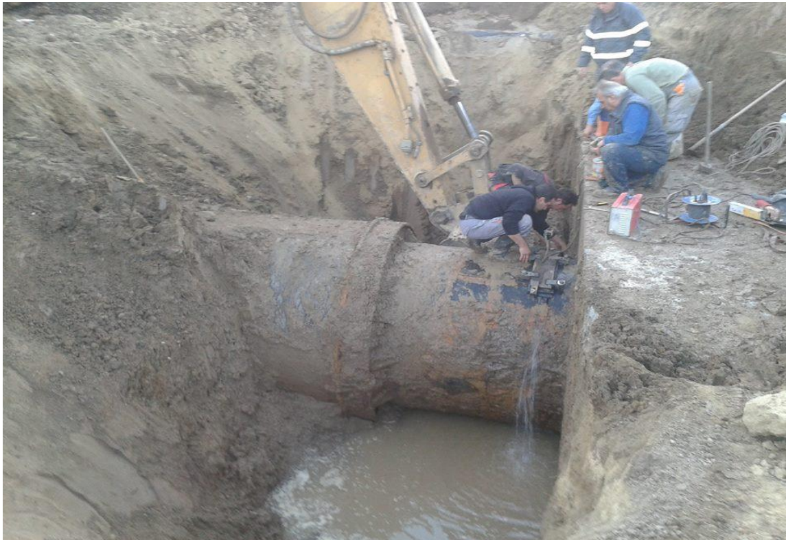
Εικόνα8: Αποκατάσταση βλάβης σε αγωγό μεταφοράς
