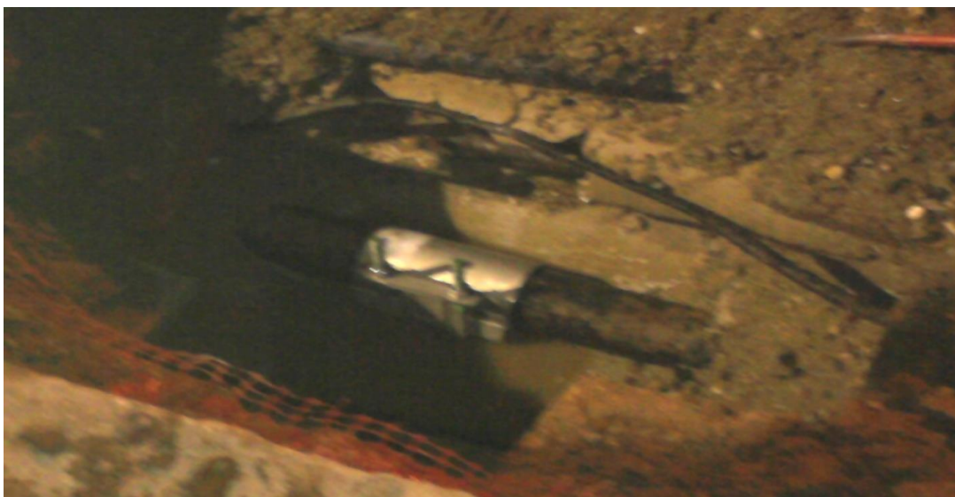
Εικόνα 7: Τοποθέτηση σέλας σε αγωγό Φ110
