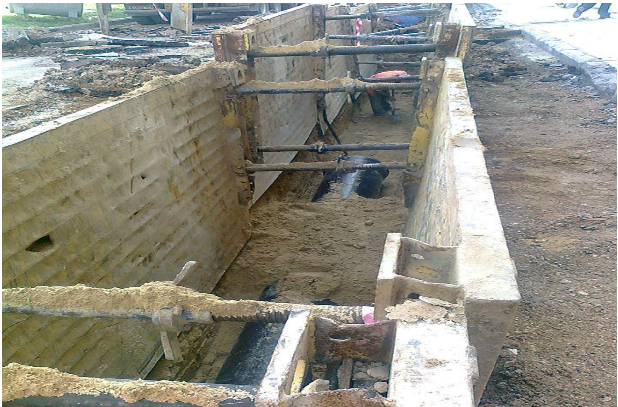
Εικόνα 10: Αντιστήριξη πρανών (σε βαθειά εκσκαφή) με χρήση krings
