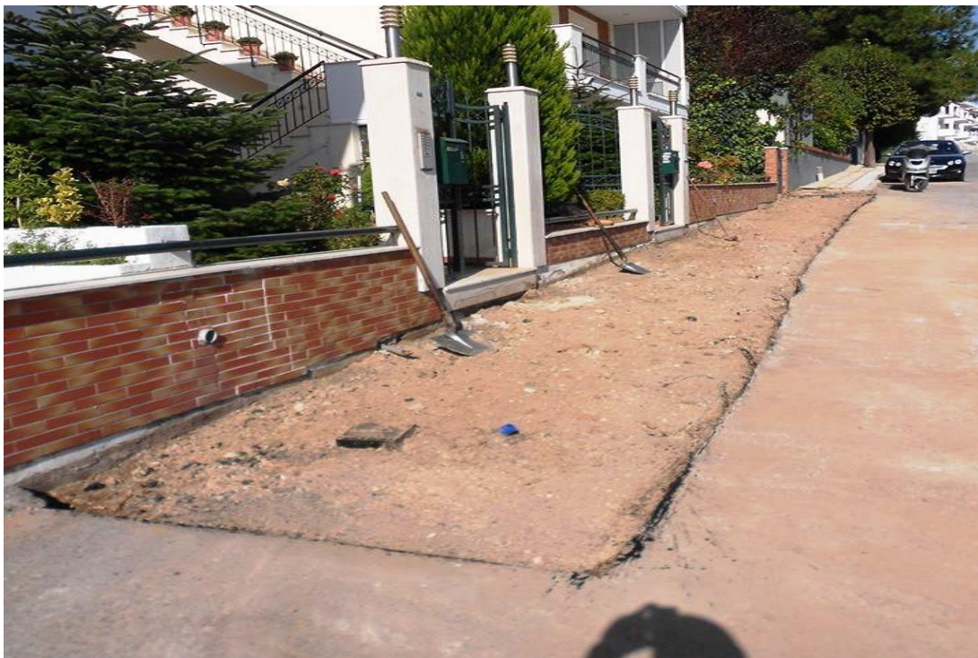
Εικόνα 11: Επίχωση ορύγματος
