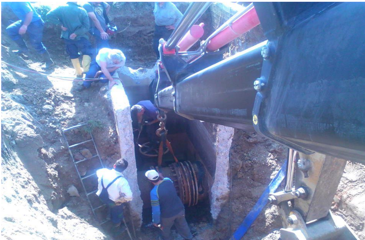
Εικόνα20: Αντικατάσταση παλαιάς δικλείδας (τύπου butterfly) Φ600.
