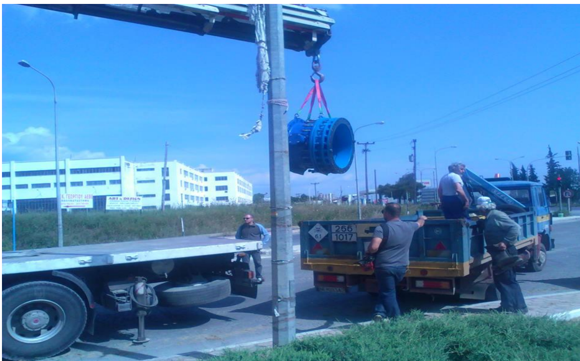
Εικόνα21: Μεταφορά νέας δικλείδας στο σημείο αντικατάστασης αυτής.
