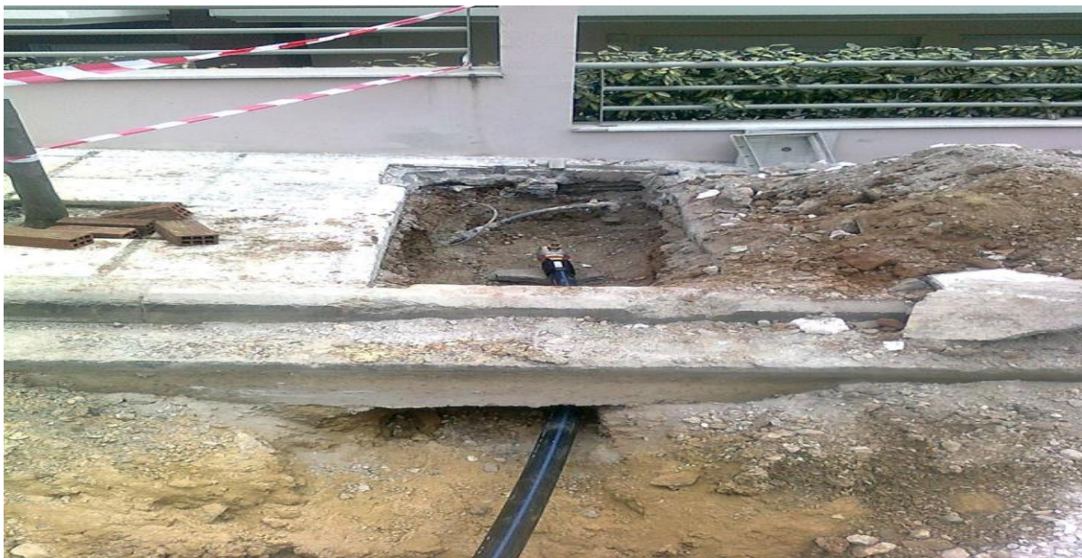
Εικόνα19: Κατασκευή διακλάδωσης Φ63 (HDPE) κάτω από το ρείθρο και το κράσπεδο πεζοδρομίου
