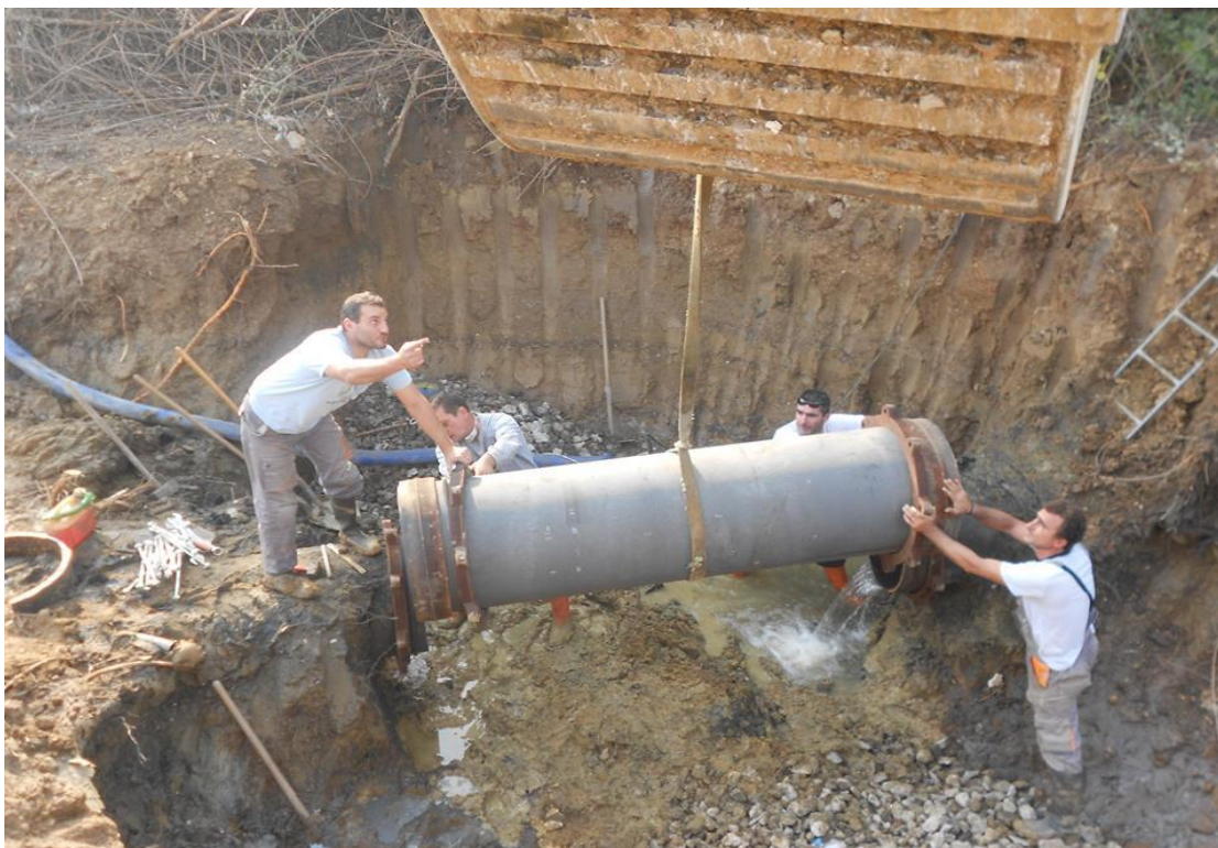
Εικόνα 2: Τοποθέτηση μέρους αγωγού μεταφοράς \Phi 600 με τη χρήση γερανού.
