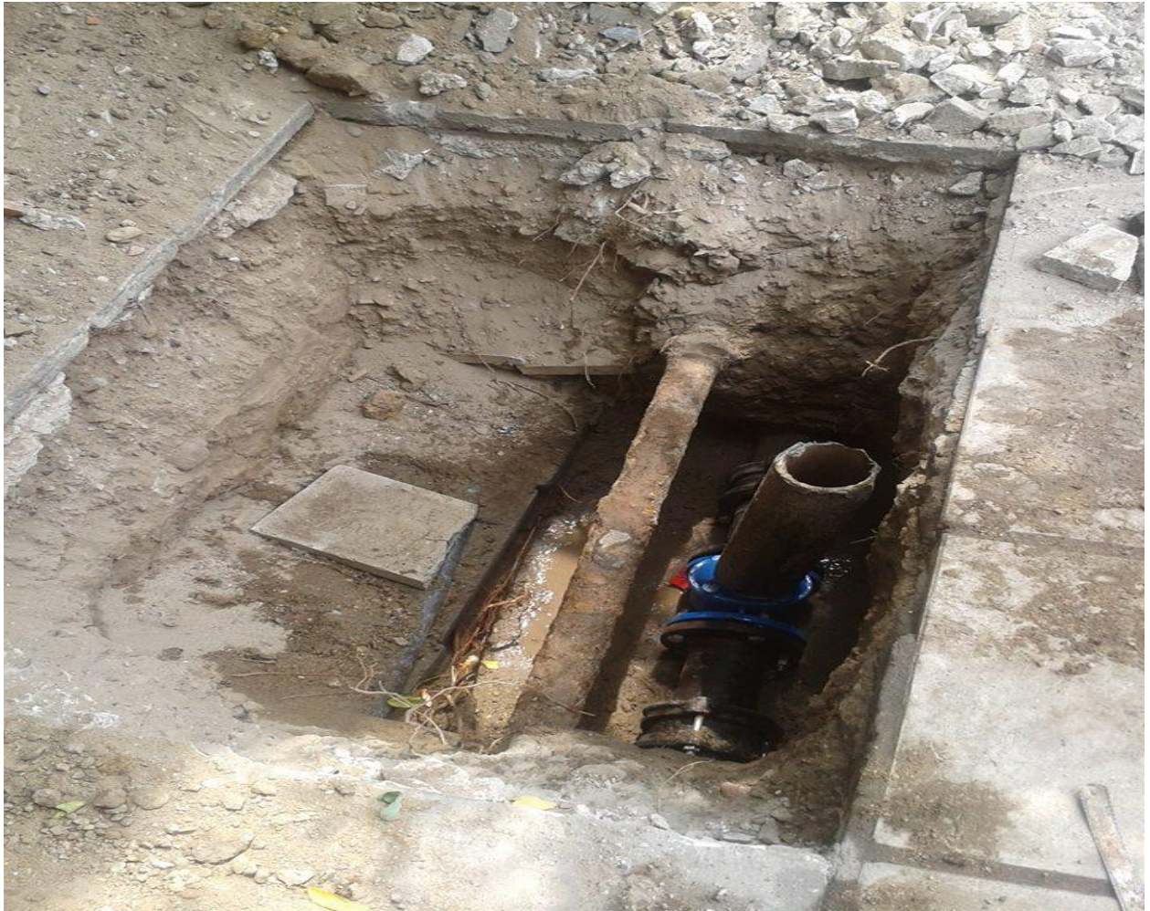
Εικόνα18 : Εκσκαφή για την αποκατάσταση βλάβης στην δικλείδα
