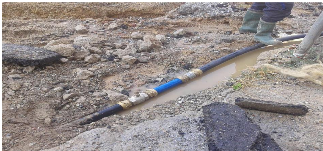
Εικόνα 5: Αντικατάσταση διακλάδωσης \Phi 63 HDPE και τοποθέτηση δικλείδας \Phi 50
