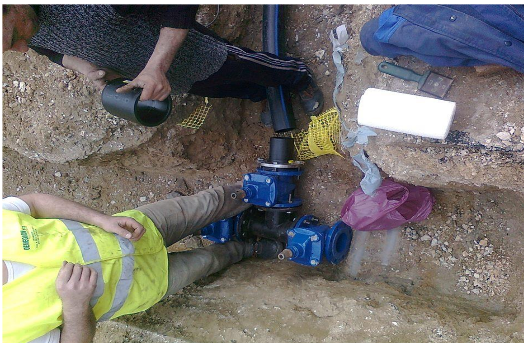
Εικόνα21:Σύνδεση ταφ (3 δικλείδων) με αγωγό Φ110 HDPE διαμέσου ηλεκτρομούφας
