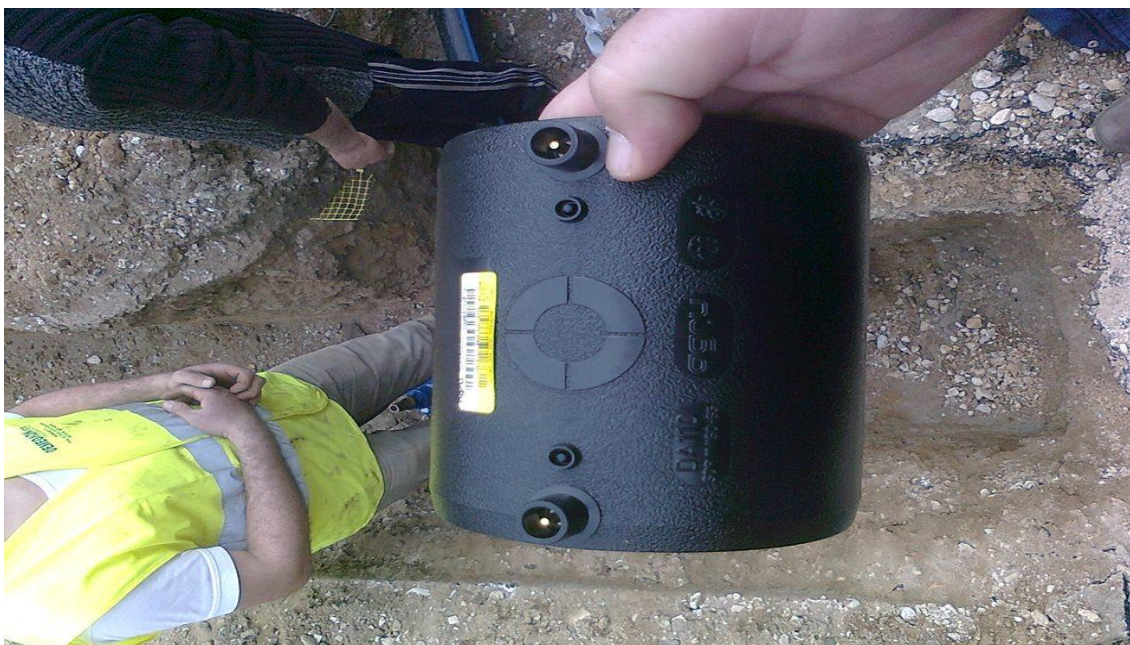
Εικόνα21: Ηλεκτρομούφα για συγκόλληση σωλήνων HDPE
