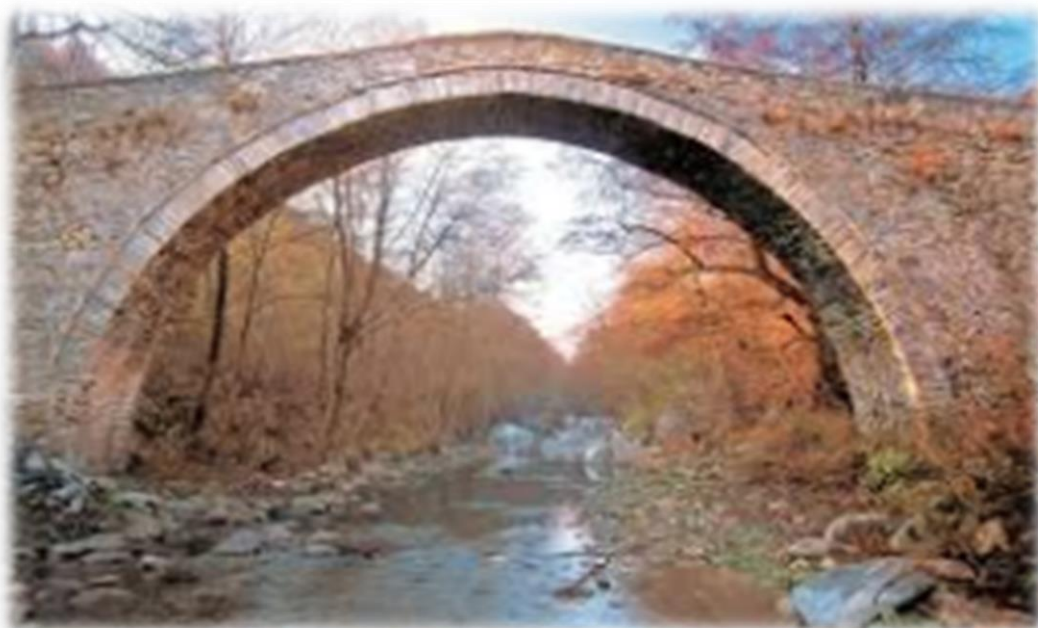
Εικόνα 5.11: Η γέφυρα του Πάπα
