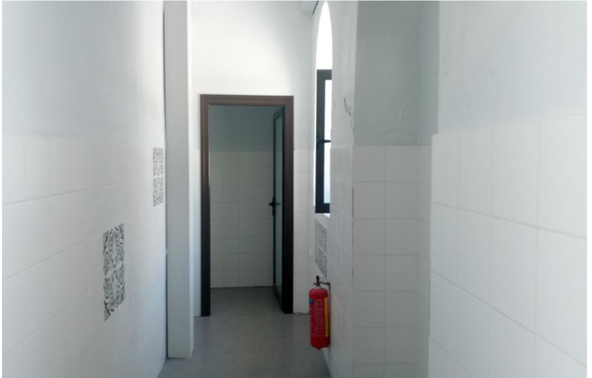
Εικόνα 4.17: Εσωτερική άποψη προθάλαμου και διακλάδωση για ατομικούς λουτήρες
