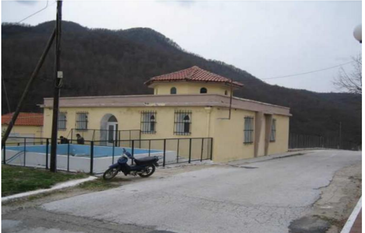
Εικόνα 4.2: Βορειοανατολική όψη κτηρίου και δεξαμενή εξισορρόπησης
