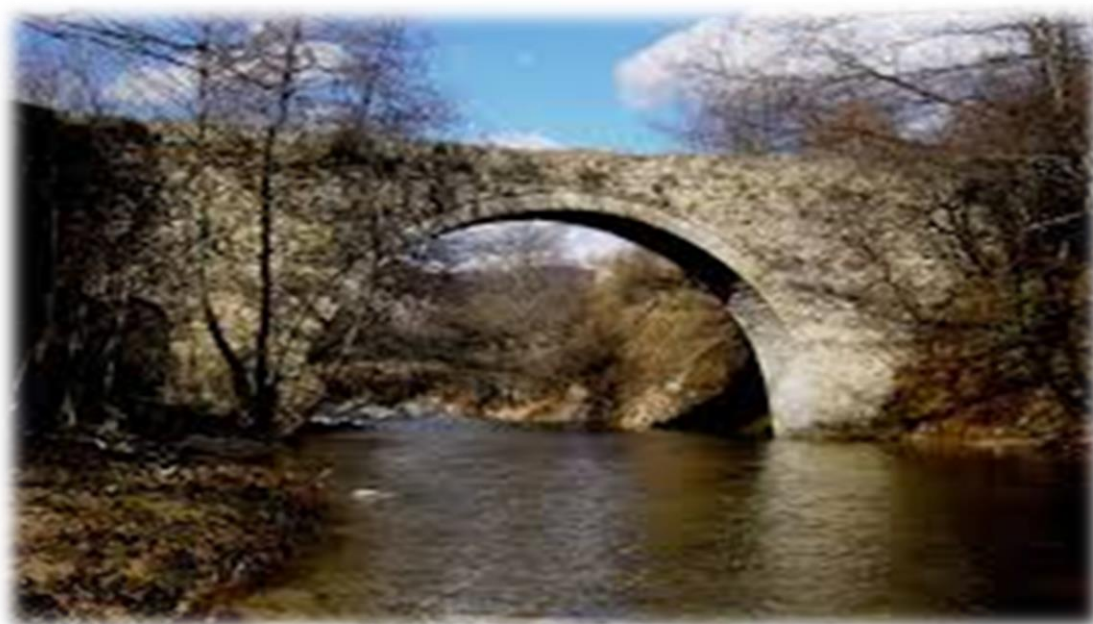
Εικόνα 5.12: Η γέφυρα του Πάπα
