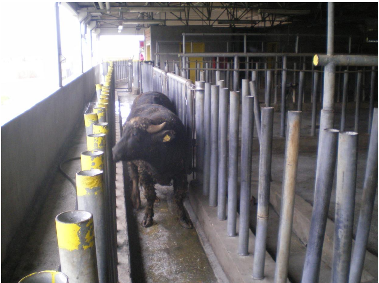
Εικόνα 13. Διάδρομος αναμονής στο σφαγείο της Kresser
