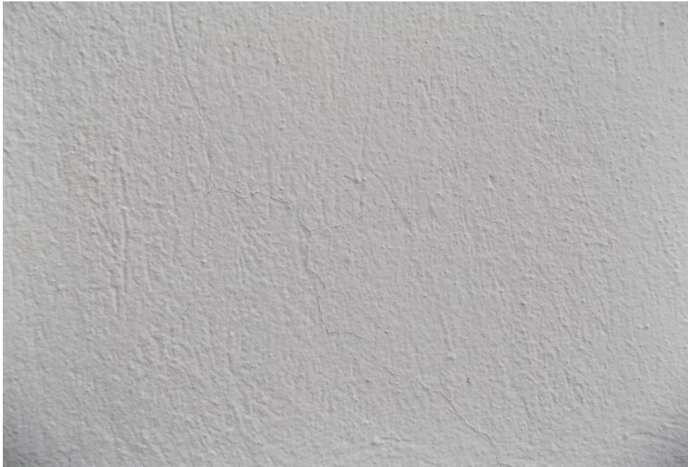
Εικόνα 38. Τοίχος Κτηρίου Οχημάτων 0.25m απόσταση
