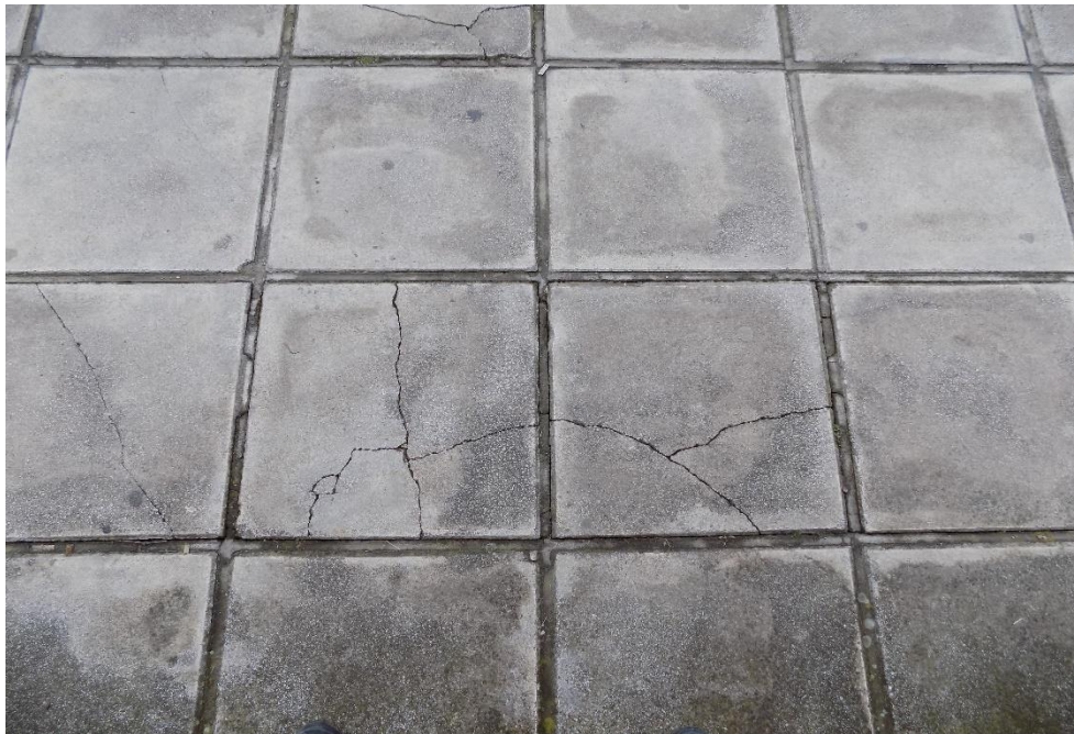
Εικόνα 45. Πλάκες πεζοδρομίου 1m απόσταση
