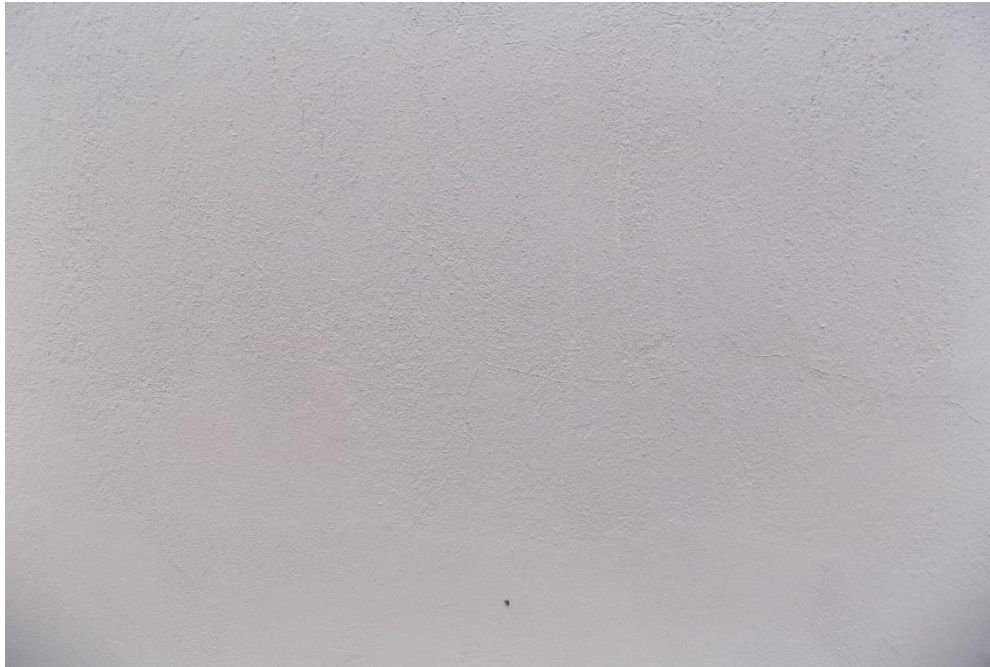
Εικόνα 25. Τοίχος Κτηρίου Οχημάτων 1m απόσταση
