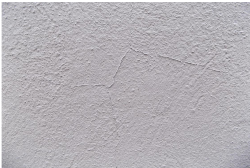
Εικόνα 28. Τοίχος Κτηρίου Οχημάτων 0.25m απόσταση
