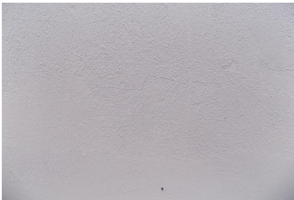
Εικόνα 26 Τοίχος Κτηρίου Οχημάτων 0.75m απόσταση
