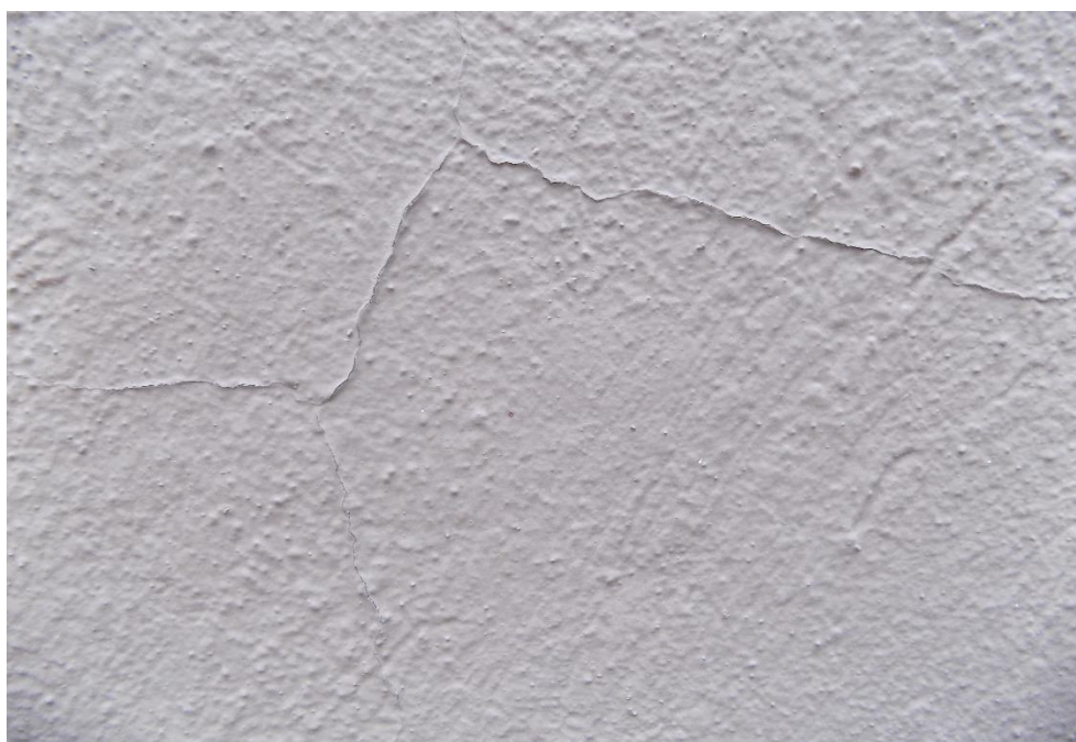
Εικόνα 29. Τοίχος Κτηρίου Οχημάτων 0.2m απόσταση
