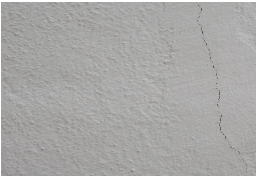
Εικόνα 20. Τοίχος Κτηρίου Διοίκησης 0.25m απόσταση
