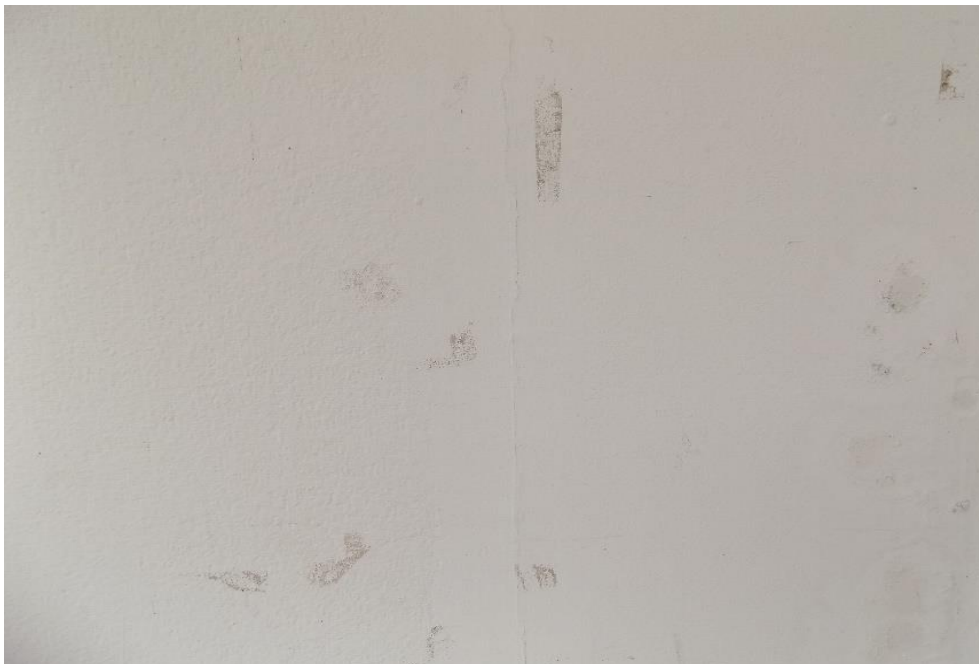
Εικόνα 10. Τοίχος Κτηρίου Αυτοματισμού 0.75m απόσταση
