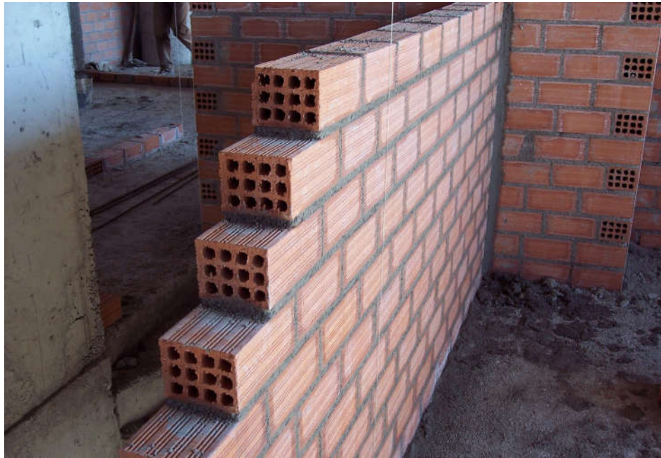
Εικόνα 34 /Δρομική τοιχοποιία
