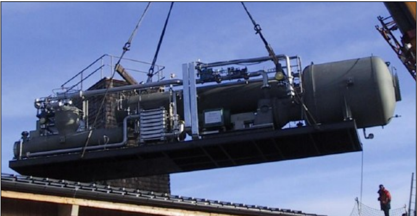
(Εικόνα 2: Στροβιλογεννήτρια ORC)
