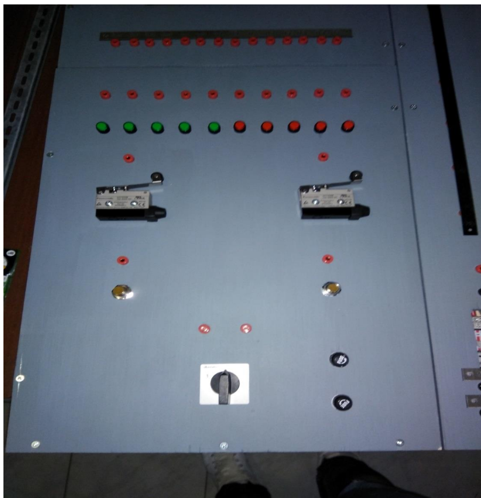
Εικόνα 68. Τοποθέτηση εξαρτημάτων εισόδων.
