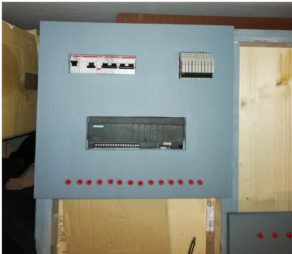
Εικόνα 69. Τοποθέτηση εξαρτημάτων τροφοδοσίας - CPU.
