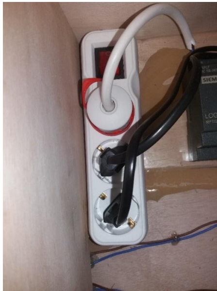
Εικόνα 38: Τοποθέτηση πολύπριζου
