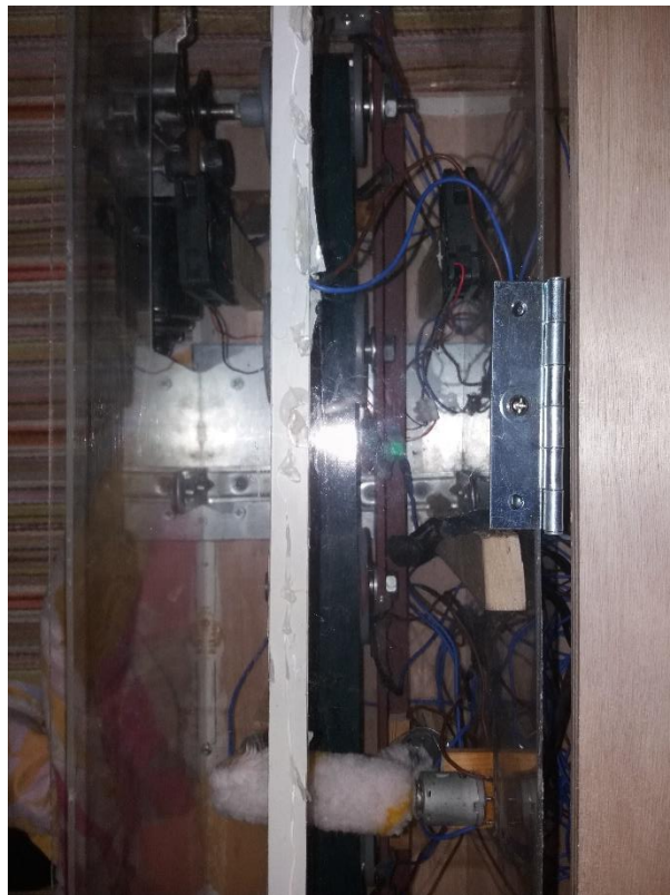
Εικόνα 44: Τοποθέτηση πλεξιγκλάς για την οροφή του πλυντηρίου
