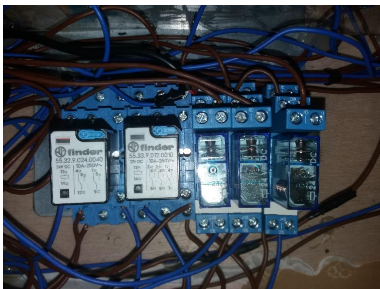
Εικόνα 35: Τοποθέτηση ρελέ
