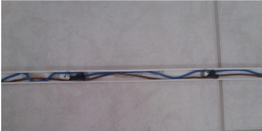
Εικόνα 41: Τοποθέτηση άσπρων LEDs για φωτισμό
