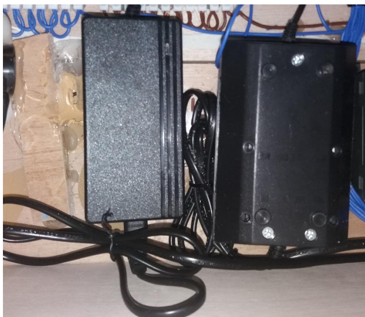
Εικόνα 32: Τοποθέτηση τροφοδοτικών
