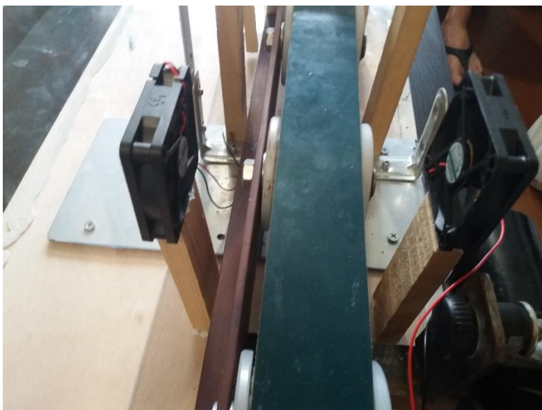
Εικόνα 28: Ξύλα στήριξης ανεμιστήρων και τοποθέτησή τους
