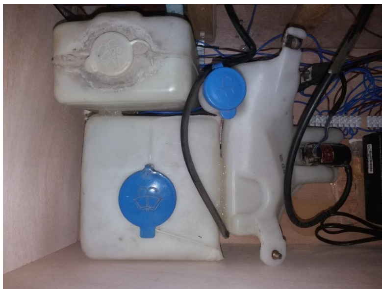
Εικόνα 33: Τοποθέτηση δοχείων ηλεκτρικών αντλιών
