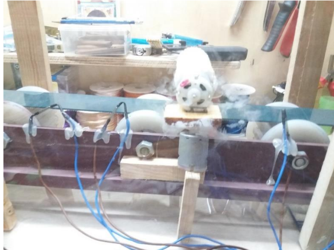
Εικόνα 39: Τοποθέτηση και στήριξη μαγνητικών διακοπών
