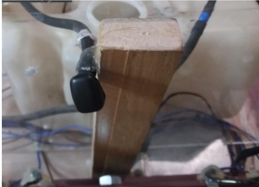
Εικόνα 30: Τοποθέτηση πιτσιλίθρας νερού 1
