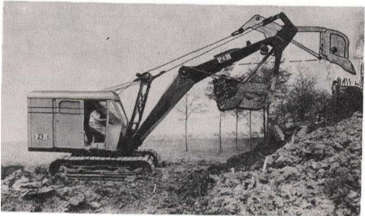
Σχ.1.5 Εκσκαφέας με ανεστραμμένο κάδο φορτώσεως
