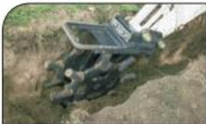
Σχ.3.27 Τροχός συμπίεσης εδάφους
