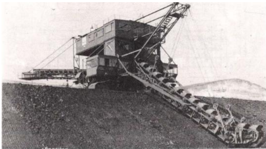
Σχ .1.1 Εκσκαφέας συνεχούς λειτουργίας με καδοφόρο αλυσίδα και μάντα αποθήσεως
