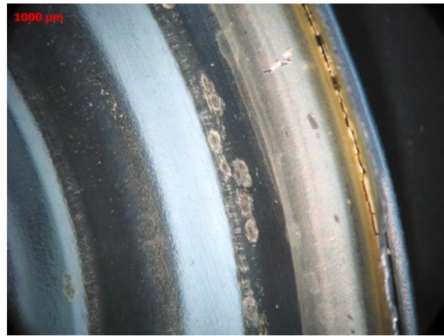
Σχήμα 45. Εκτεταμένες διαβρώσεις στην περιοχή του πυθμένα
