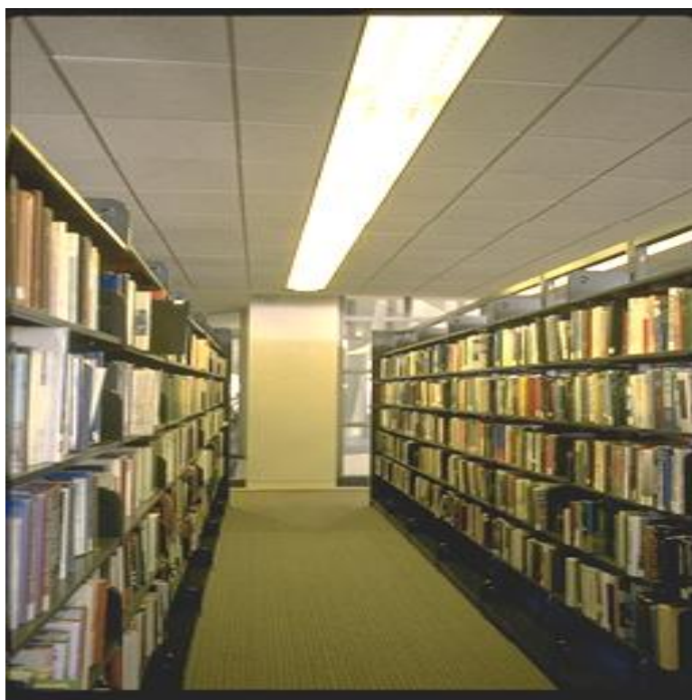
Εικόνα 14: Μέθοδος φωτισμού, παράλληλου προς τα βιβλιοστάσια, όπου το αποτέλεσμα είναι ομοιόμορφο από το άνω ως το κατώτατο ράφι.
