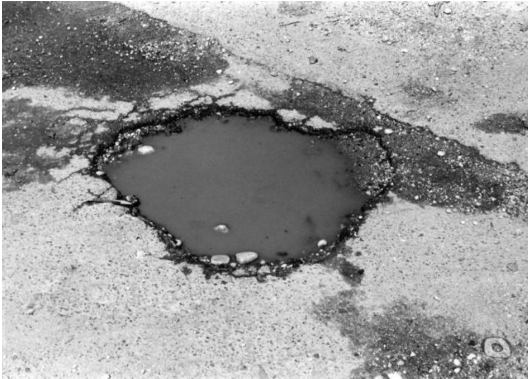
Εικόνα 1.19 Λακκούβα ( www.asphaltinstitute.org )
