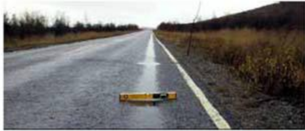
Εικόνα 2.5 Συσσώρευση νερού στο ίχνος τροχού (Dawson and Kolisoja, 2004)
