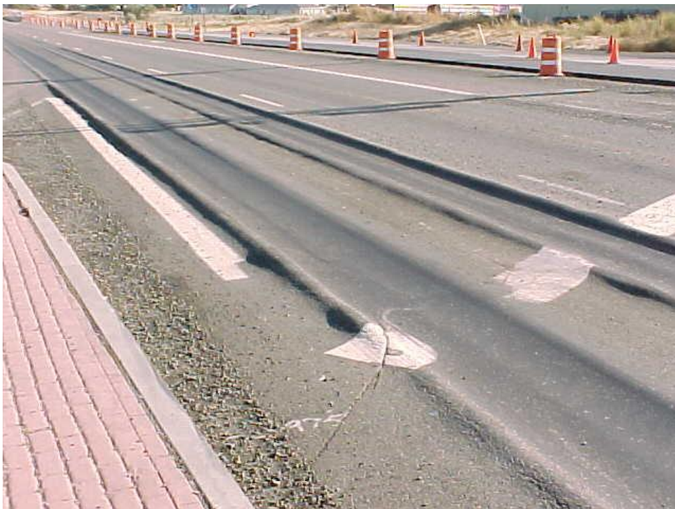
Εικόνα 1.14 Τροχαυλακώσεις ( www.pavementinteractive.org )
