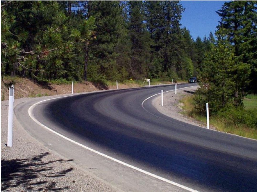
Εικόνα 1.23 Ανάδυση ασφάλτου λόγω υπερβολικής ποσότητας ασφάλτου ( www.pavementinteractive.org )
