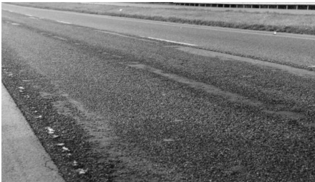
Εικόνα 1.17 Αποκόλληση αδρανών ( www.asphaltinstitute.org )
