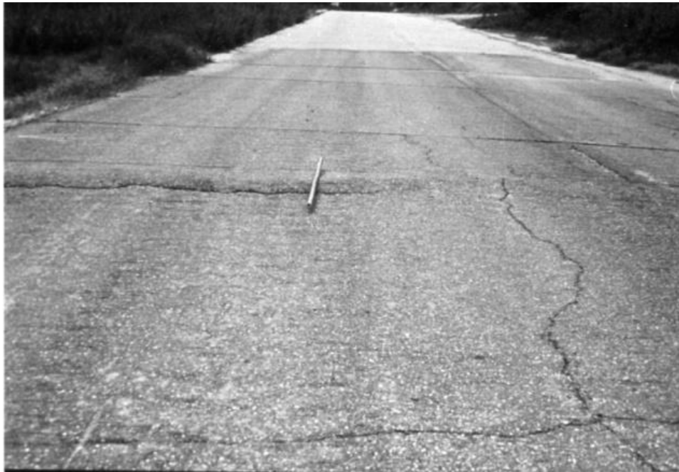
Εικόνα 1.16 Τοπικές διογκώσεις ( www.asphaltinstitute.org )
