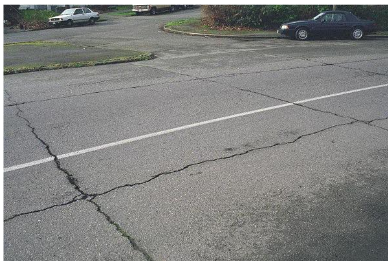
Εικόνα 1.7 Ρωγμές από ανάκλαση ( www.pavementinteractive.org )
