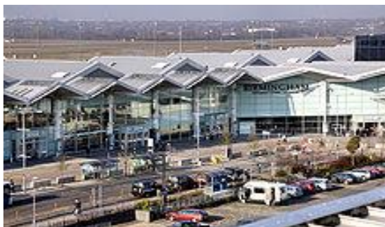
Εικόνα 10: Τερματικό 2: Διεθνής αερολιμένας του Μπέρμιγχαμ
