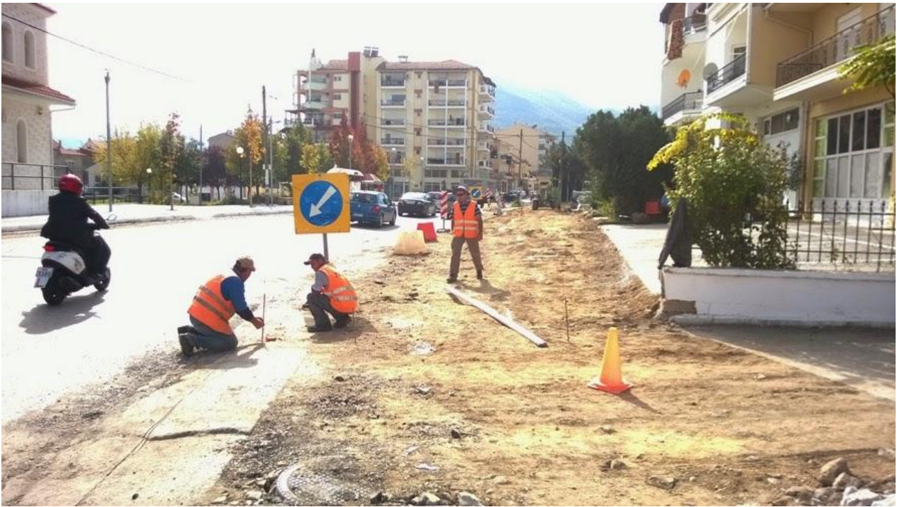
Εικόνα 3.3. Εκτροπή κυκλοφορίας με την κατάλληλη σήμανση, εργασίες επίχωσης εδαφικών στρωμάτων.
