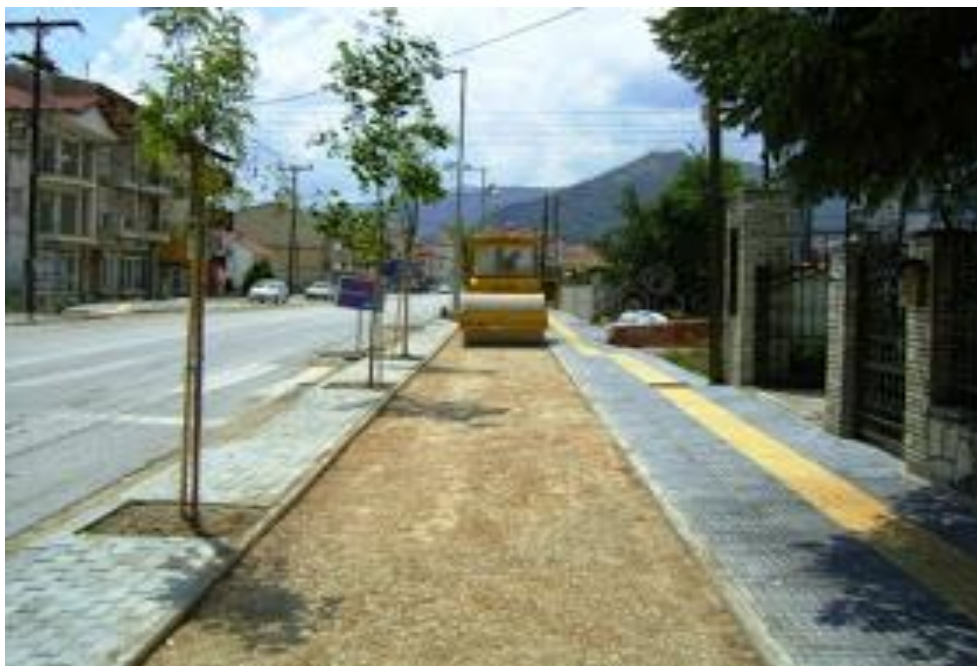
Εικόνα 3.7. Ισοπέδωση των πρανών, προετοιμασία ασφαλτόστρωσης.
