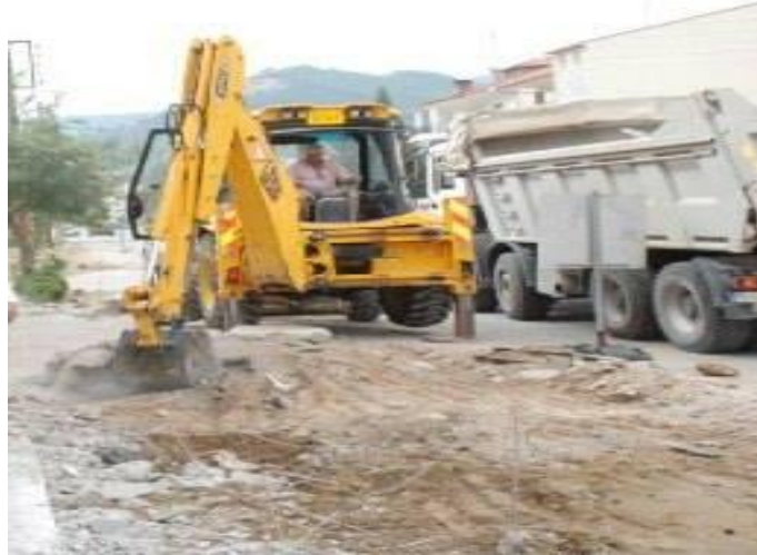
Εικόνα 3.2. Από το στάδιο της αποξήλωσης της οδού.
