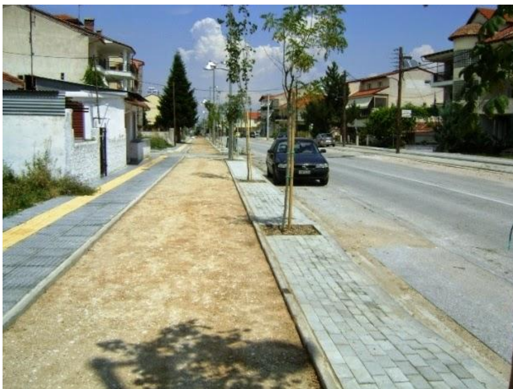
Εικόνα 3.5. Έπειτα από την ολοκλήρωση των εργασιών των κρασπέδων.
