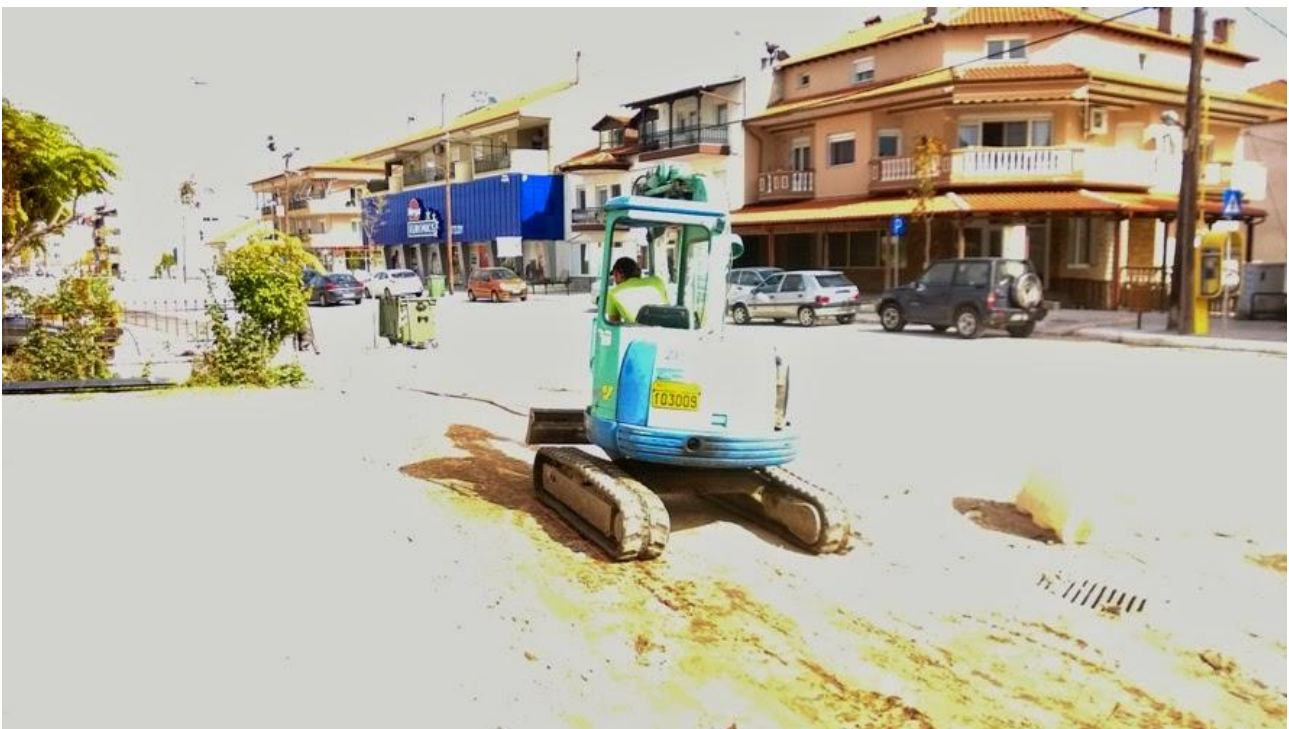
Εικόνα 3.4. Εργασίες από την αφαίρεση του ασφαλτικού τάπητα.
