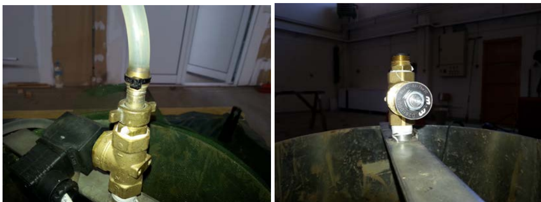
Εικόνα 9. Ηλεκτρικός διακόπτης ροής D266DBU
