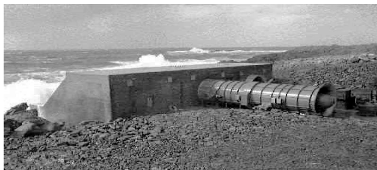
Εικόνα 11 : Το σύστημα ταλαντευόμενης στήλης νερού LIMPET (Clément et al. 2002)
