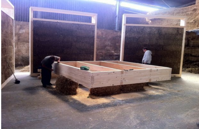
Εικόνα 33. Κατασκευή του κτιρίου Inspire Bradford Business Park με πάνελ της εταιρείας Modcell
