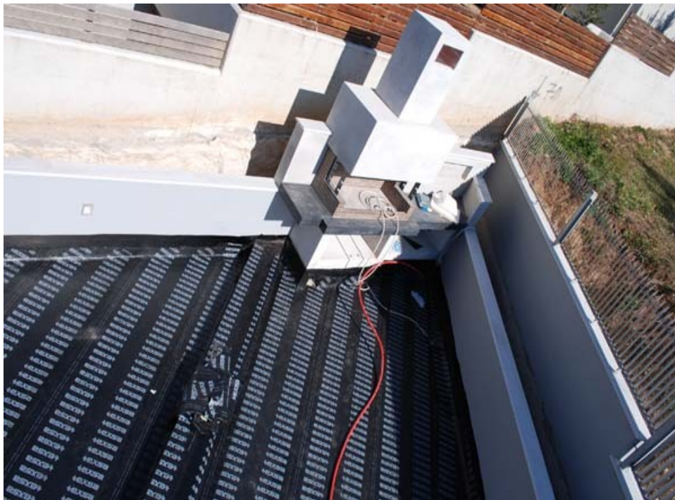
Εικόνα 4. Στεγάνωση επιφάνειας
