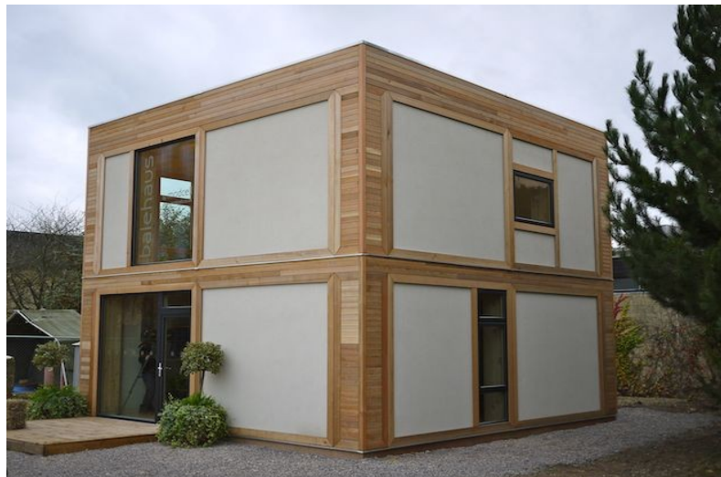
Εικόνα 34. Το διώροφο κτίριο BaleHaus, στο χώρο του πανεπιστημίου του Bath με πάνελ της εταιρείας ModCell
