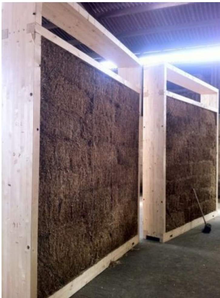
Εικόνα 32. Κατασκευή του κτιρίου Inspire Bradford Business Park με πάνελ της εταιρείας Modcell
