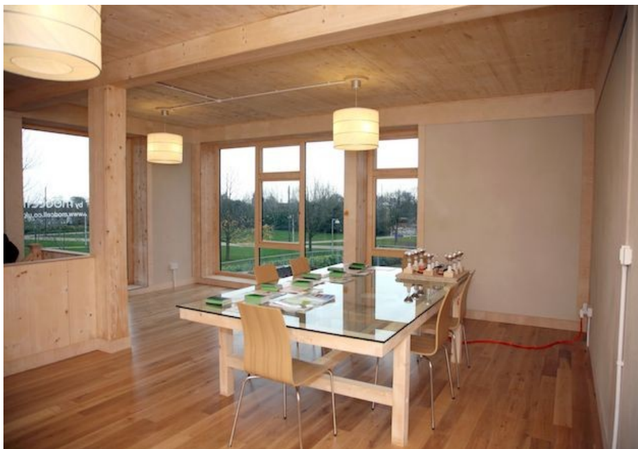
Εικόνα 36. Εσωτερικό του κτιρίου BaleHaus με πάνελ της εταιρείας ModCell
