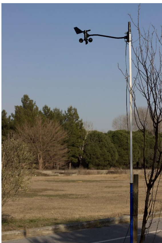
Εικόνα 6-6 Το ανεμόμετρο εγκατεστημένο στον πειραματικό χώρο.
