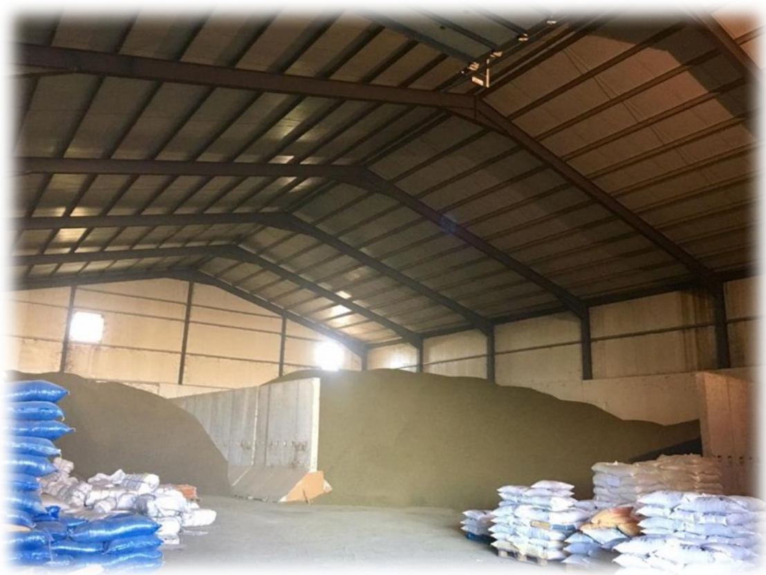
Εικόνα 5: Αποθηκευτικός χώρος πρώτων υλών για ζωτροφές.
