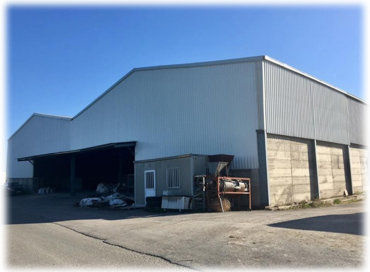
Εικόνα 1: Αποθήκες παραλαβής, επεξεργασίας και αποθήκευσης σπόρων.
