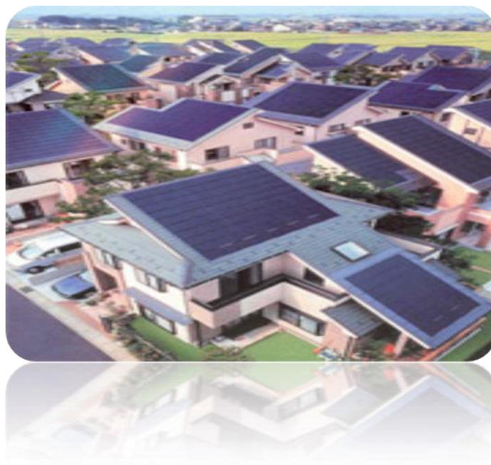
Εφαρμογή φωτοβολταϊκού συστήματος
