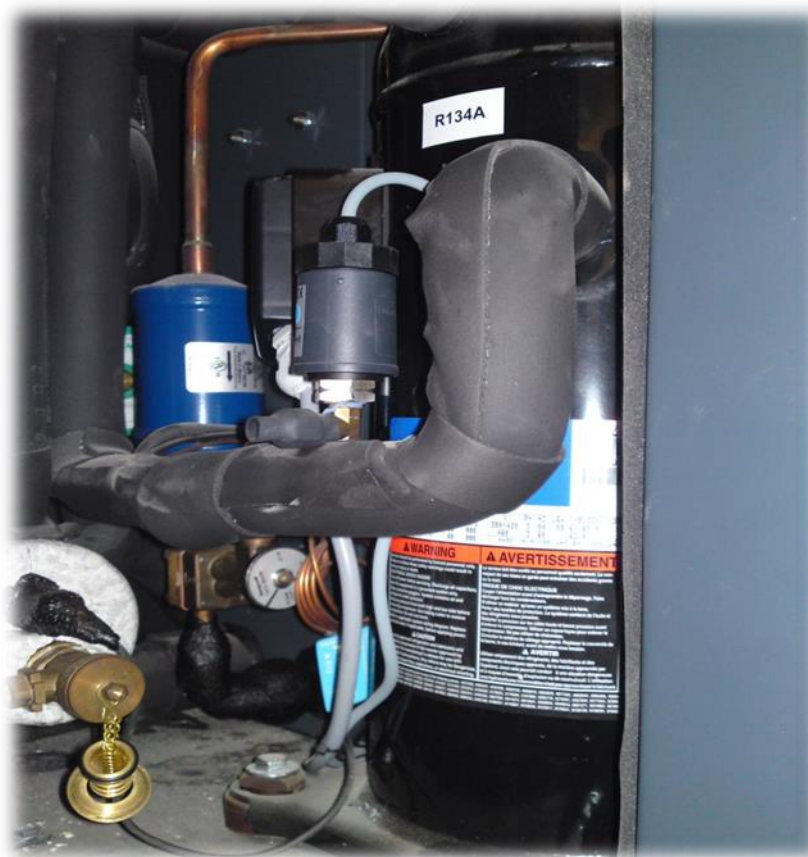
Εμφανιζόμενα εξαρτήματα αντλίας. α) Συμπιεστής β) Εκτονωτής γ) Βαλβίδα εκτόνωσης δ) Εναλλάκτης
