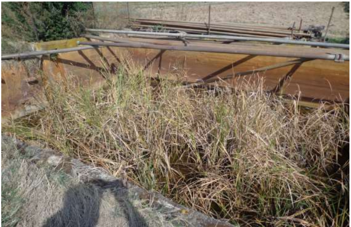
Εγκαταλειμμένη δεξαμενή ανάμειξης υπόγειων νερών διαφορετικής ποιότητας
