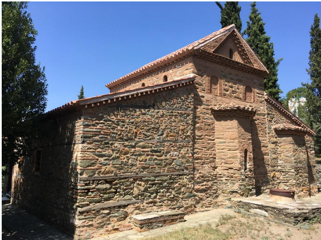
Εικόνα 88: Αποψη της ανατολικής πλευράς του ναού
