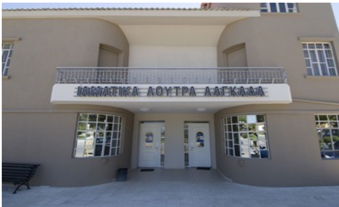
ΕΙΚΟΝΑ 2. ΠΡΟΣΟΨΗ ΤΩΝ ΕΓΚΑΤΑΣΤΑΣΕΩΝ ΤΗΣ ΕΠΙΧΕΙΡΗΣΗΣ ΛΟΥΤΡΩΝ ΛΑΓΚΑΔΑ
