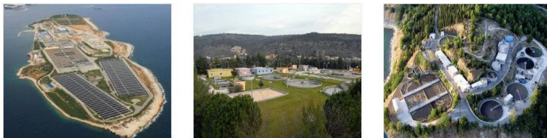
Εικ.28: Μονάδες ΕΕΛ, σε Ψυττάλεια, Άρτα και Καβάλα. Μετά την έξοδο των λυμάτων από τις ΕΕΛ, προκύπτει μείωση των αιωρούμενων στερεών: Από 230mg/lt στα 10 mg/lit, και του BOD5(βιοχημικά απαιτούμενου οξυγόνου πέντε ημερών), από 250 mg/lit στα 10 mg/lit (ΥΠΕΚΑ, 2018).
