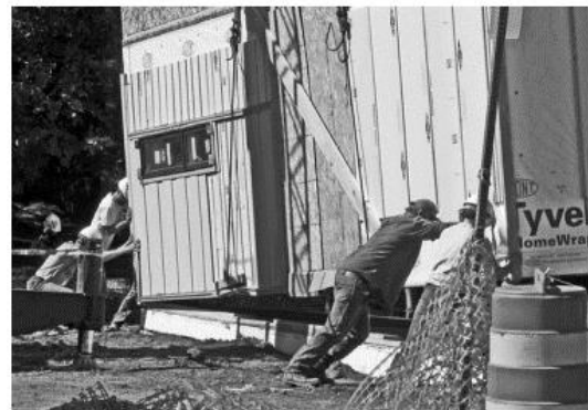
Σχήμα 2.10 Φωτογραφική απεικόνιση της διαδικασίας διαχείρισης κατά την ανέλκυση και επικείμενη τοποθέτηση του «προκάτ» τμήματος (Smith, 2011).
