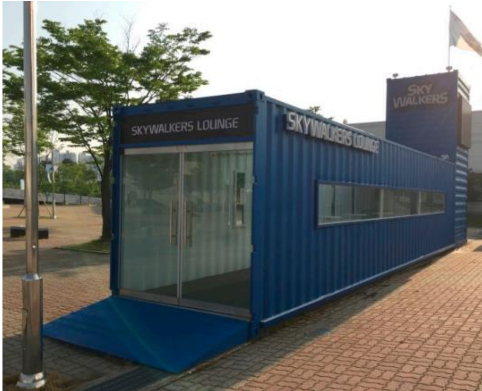
Σχήμα 2.4 Φωτογραφία πρότυπης κατασκευής μεταλλικού δομικού κτηρίου με την εφαρμογή μεταλλικών πάνελ τύπου isobox.
