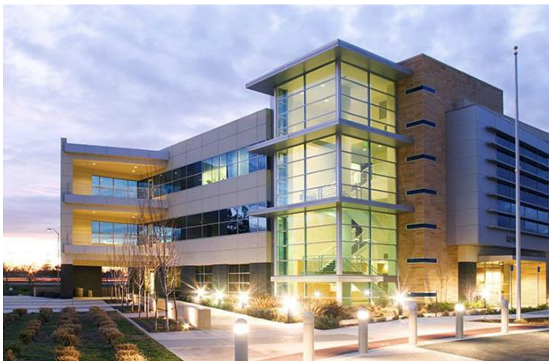
Σχήμα 1.5 Τριώροφες κτιριακές εγκαταστάσεις σε σύγχρονη αρχιτεκτονική σχεδίαση, κατασκευασμένα στα πρότυπα των αρθρωτών κτιρίων (modular) (ABM, 2018).
