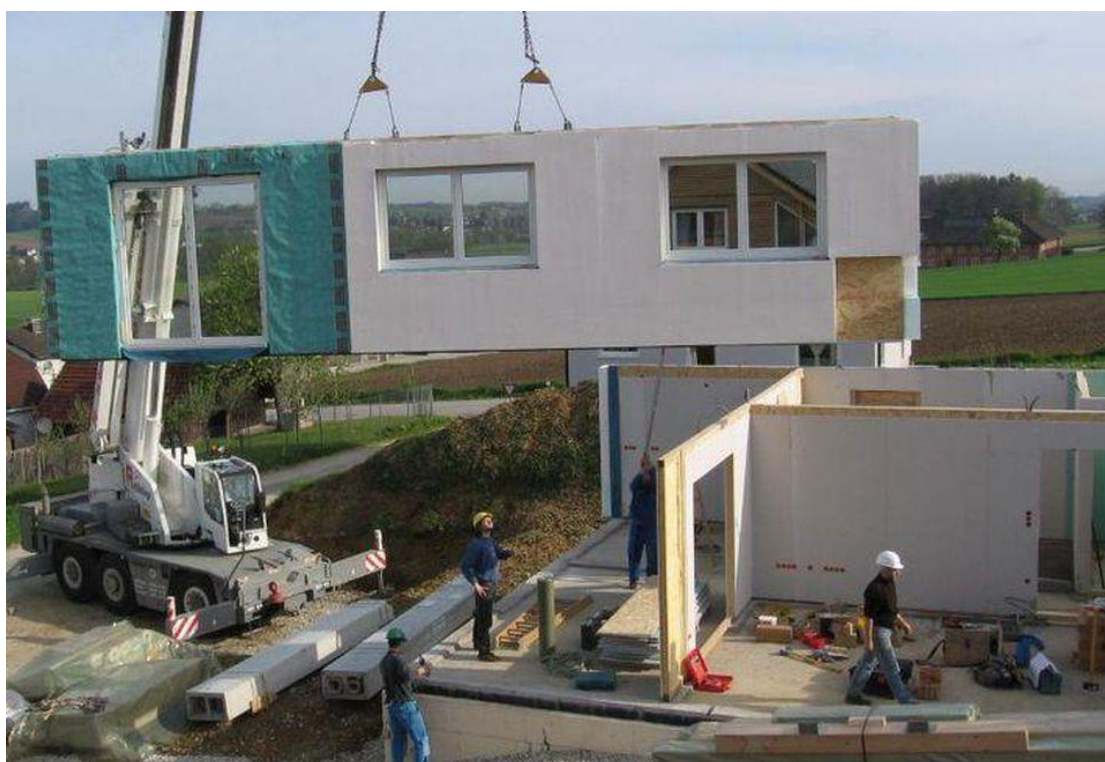
Σχήμα 1.3 Αναπαράσταση τοποθέτησης τμήματος προκατασκευασμένου κτιρίου στο εργοτάξιο (Bunch, 2017).
