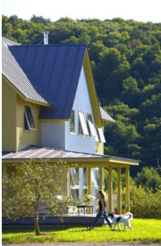
Σχήμα 3. 2 Φωτογραφία οικοδομήματος περίπτωσης μελέτης (WBDG, 2018)
