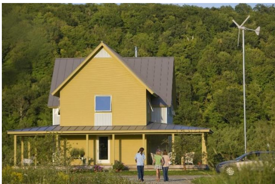
Σχήμα 3.1 Φωτογραφία οικοδομήματος περίπτωσης μελέτης (WBDG, 2018).
