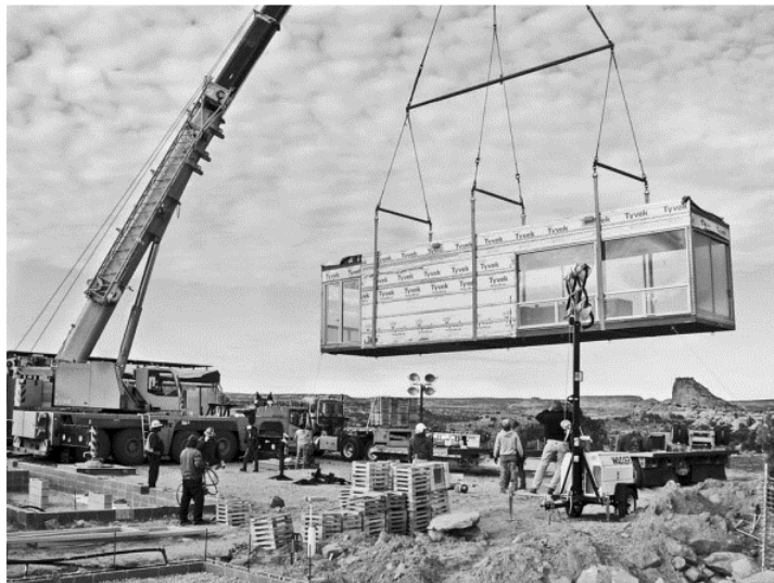
Σχήμα 2.9 Φωτογραφική απεικόνιση της εναέριας απόθεσης τμήματος προκατασκευασμένου κτηρίου (Smith, 2011)
