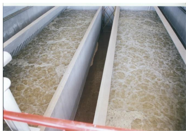
Σχήμα 12: Αριστερά: Δίδυμες κλίνες άμμου και δεξιά: μονές κλίνες άμμου-ανθρακίτη (Πηγή: http://www.eydeael.gr )
