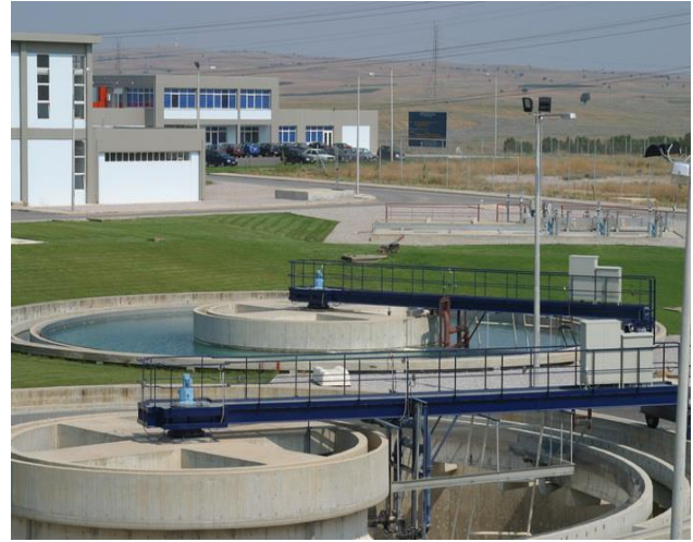
Σχήμα 11: Δεξαμενές κροκίδωσης και καθίζησης (Πηγή: http://www.eydeael.gr )
