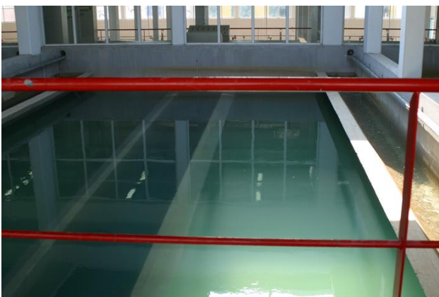
Σχήμα 12: Αριστερά: Δίδυμες κλίνες άμμου και δεξιά: μονές κλίνες άμμου-ανθρακίτη (Πηγή: http://www.eydeael.gr )
