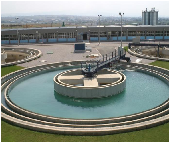
Σχήμα 11: Δεξαμενές κροκίδωσης και καθίζησης (Πηγή: http://www.eydeael.gr )
