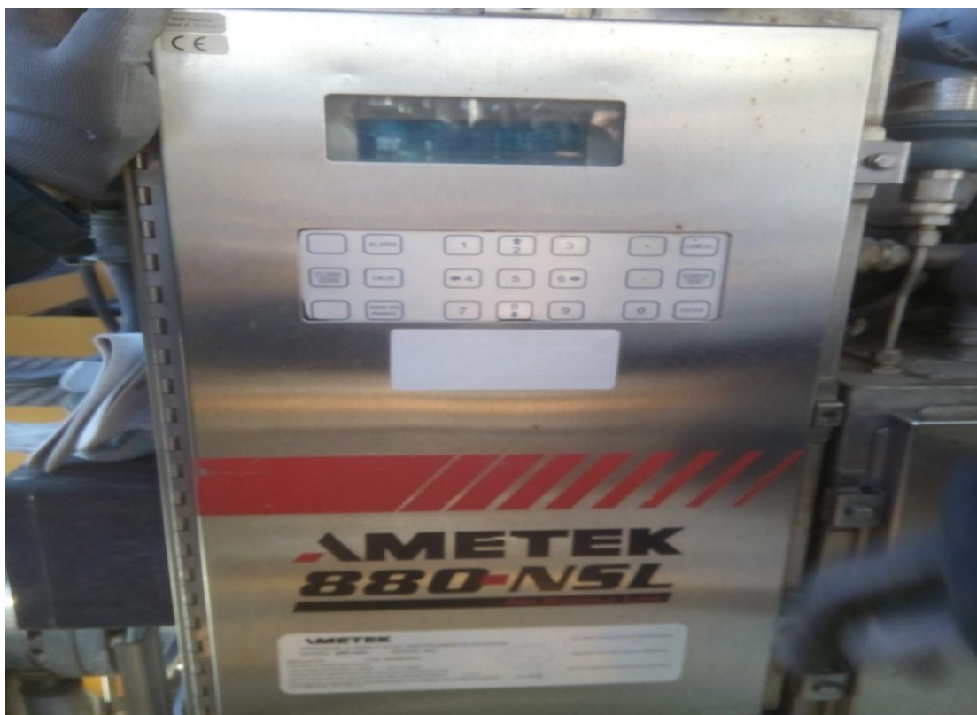
Εικόνα 2.3 Εξωτερικό περίβλημα του πίνακα ελέγχου του αναλυτή υδροθείου και διοξειδίου του άνθρακα μέσα από το εργοστάσιο.
