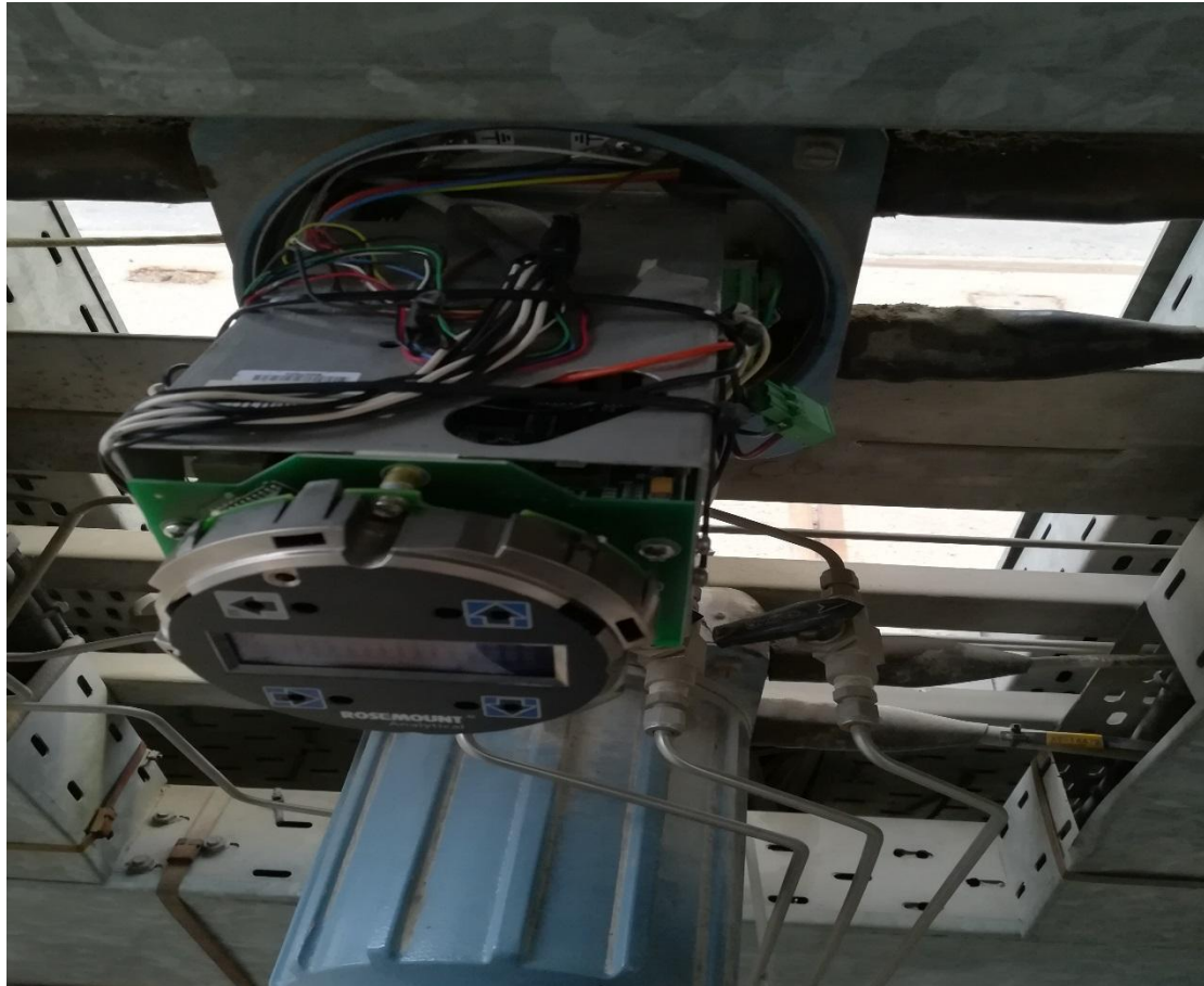
Εικόνα 1.3.5. Εσωτερικό αναλυτή οξυγόνου , το ηλεκτρονικό αυτό σύστημα είναι ο ενδείκτης
