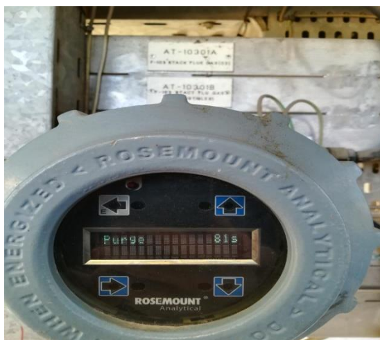
Εικόνα 1.2.12 Εκκαθάριση αερίων από το σύστημα σωληνώσεων
