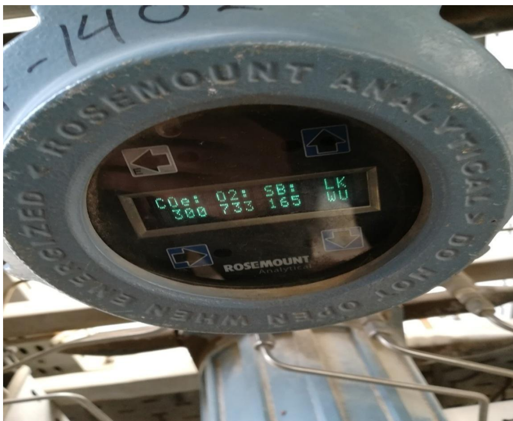
Εικόνα 1.1.2 Ο ενδείκτης, η οθόνη που ελέγχουμε το κύριο σώμα του αναλυτή.
