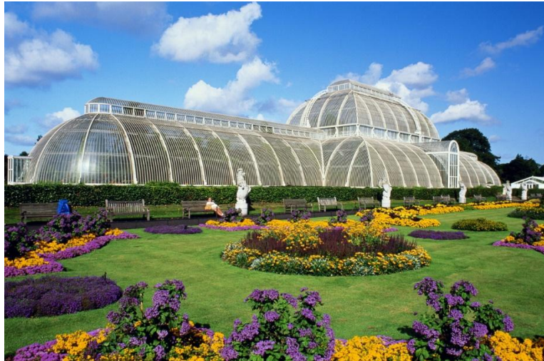
Εικ.8 Ένα θερμοκήπια του πάρκου- Kew Gardens (Πηγή Διαδίκτυο)
