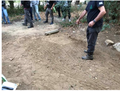
Εικ.31 Ισοπέδωση (Πηγή Α.Τ.)
