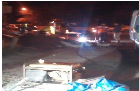
Εικόνα 23. Νυχτερινές εργασίες - Νυχτερινή φωτεινή σήμανση
