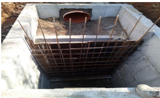
Εικόνα 18. Κατασκευή κεντρικού φρεατίου αποχέτευσης με υπερχειλιστή
