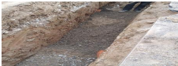
Εικόνα 20. Προετοιμασία σκάμματος για τοποθέτηση αγωγού ακαθάρτων
