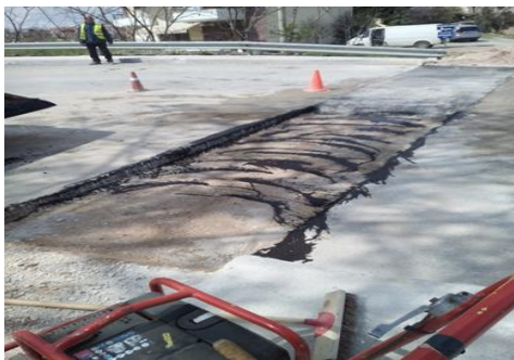
Εικόνα 12. Εργασίες ασφαλτόστρωσης
