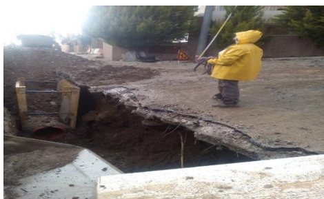
Εικόνα 14. Εγκατάσταση κεντρικού αγωγού σε συνθήκες βροχερού καιρού
