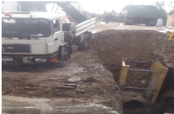
Εικόνα 4. Μεταλλικές αντιστήριξης τύπου grenks
