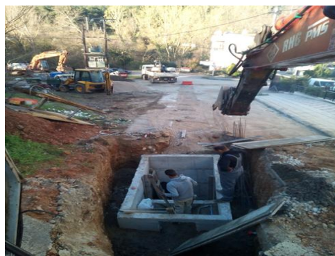
Εικόνα 9. Κατασκευή κεντρικού φρεατίου
