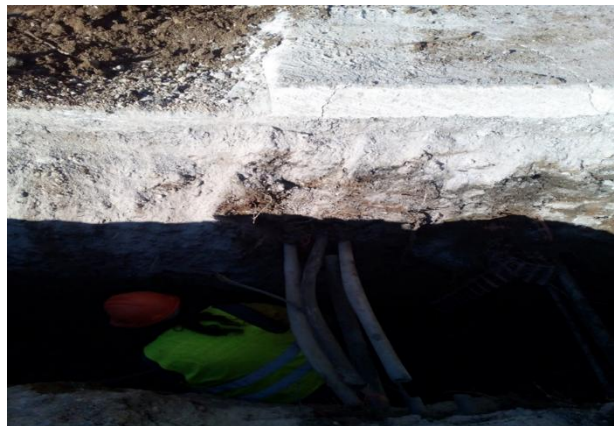
Εικόνα 17. Κατασκευή δικτύου αποχέτευσης – διέλευση εμποδίων
