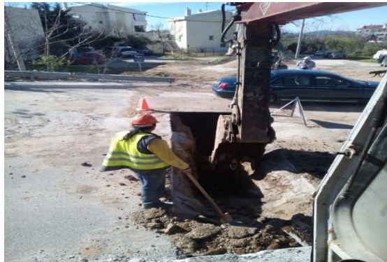
Εικόνα 16. Εργασίες κατασκευής δικτύου αποχέτευσης
