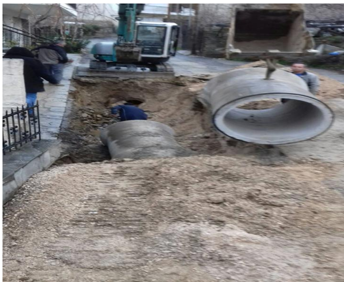
Εικόνα 3. Σύνδεση ιδιωτικής διακλάδωσης με εσωτερικό δίκτυο οικοπέδου
