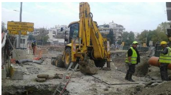
Εικόνα 1. Εργασίες πάνω στο έργο
