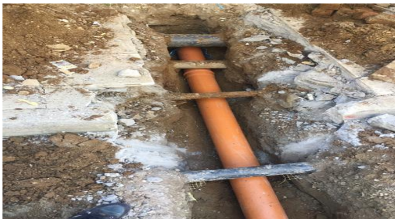
Εικόνα 2. Τοποθέτηση αγωγού ιδιωτικής διακλάδωσης αποχέτευσης
