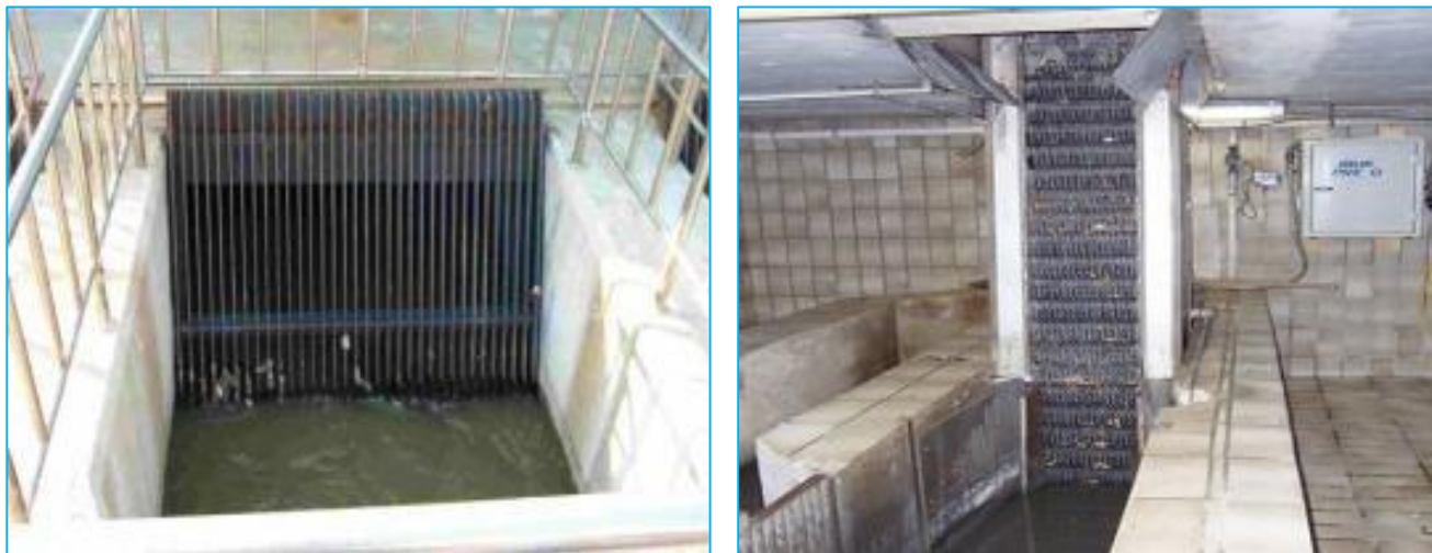
Σχήμα 6: Σχάρες από το στάδιο της εσχάρωσης
