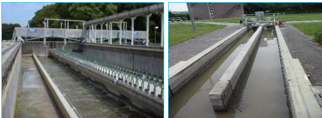
Σχήμα 7: Αμμοσυλλέκτης – δεξαμενή καθίζησης
