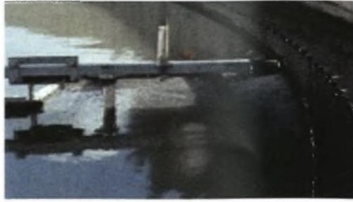
Εικόνα 7-4 Μηχανισμός αφαίρεσης των ουσιών που επιπλέουν. (Ράμμος, 2006)
