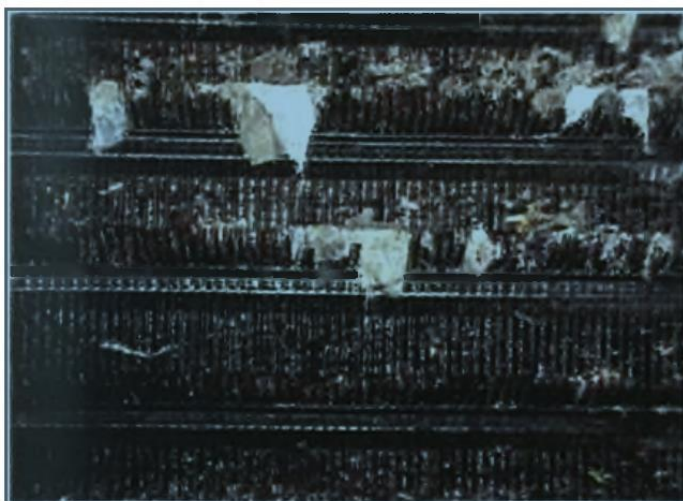
Εικόνα 7-2 Σχάρες συγκράτησης στερεών αντικειμένων. (Ράμμος, 2006)
