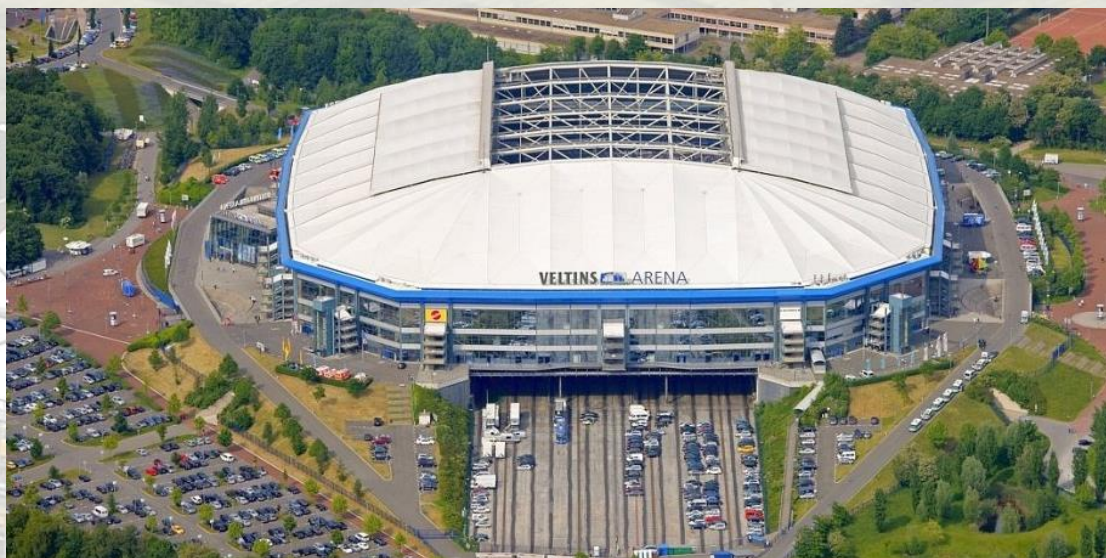
Εικόνα 9 Ποδοσφαιρικό γήπεδο Arena Aufschalke
