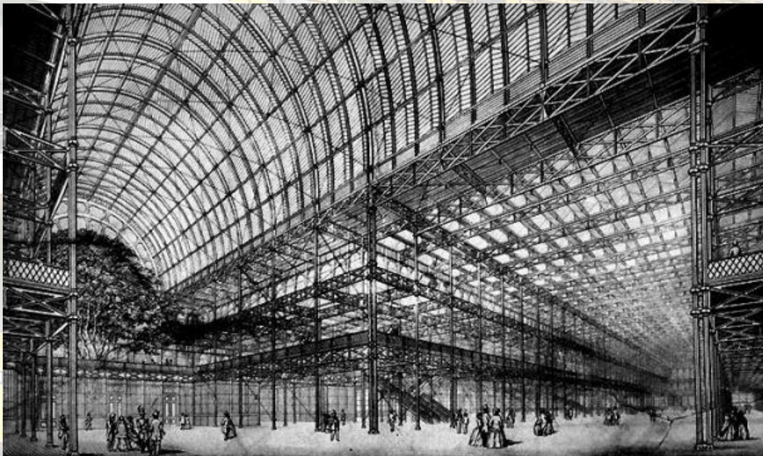
Εικόνα 13 Crystal Palace-Paxton, Εσωτερική άποψη(Πηγή: http://wwwdata.unibg.it )
