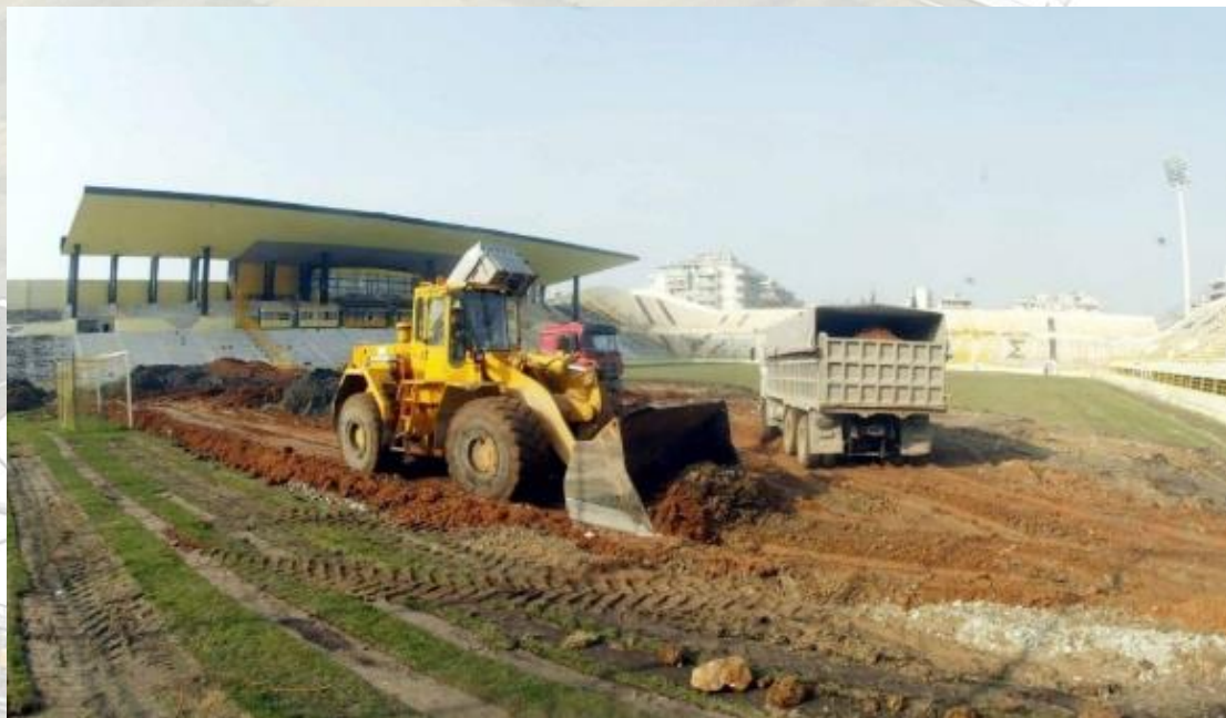
Εικόνα 39 Φάση εργασιών ανακατασκευής σταδίου Άρεως- Πηγή: allaboutaris.com
