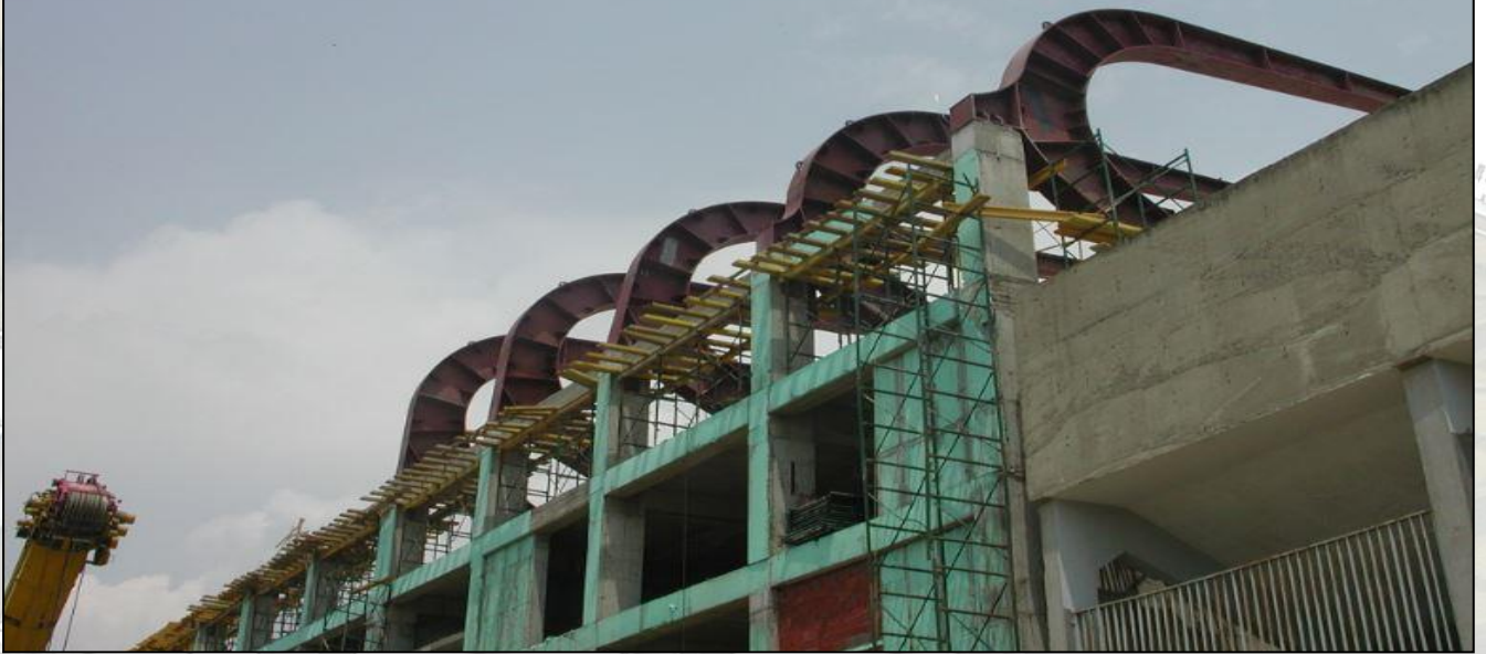
Εικόνα 61 Εναέριες εργασίες τοποθέτησης τεγίδων
