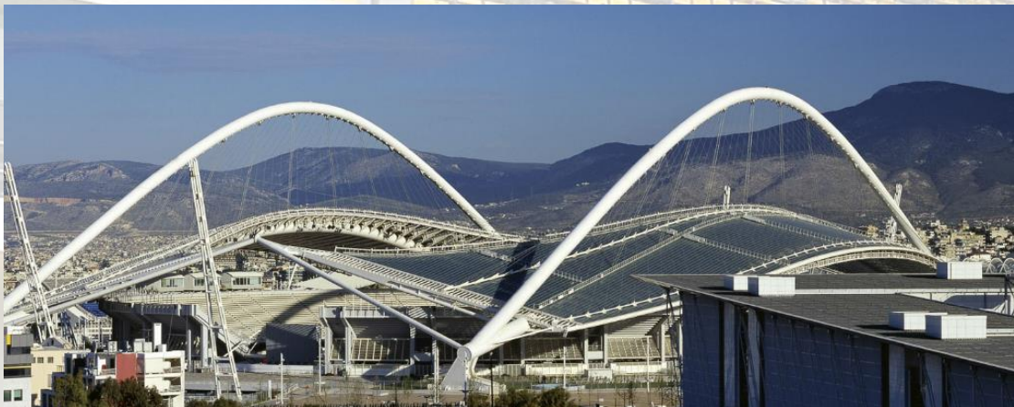
Εικόνα 26 Τοξωτό σύστημα- Ολυμπιακό Στάδιο Αθηνών- Πηγή: Calatrava.com
