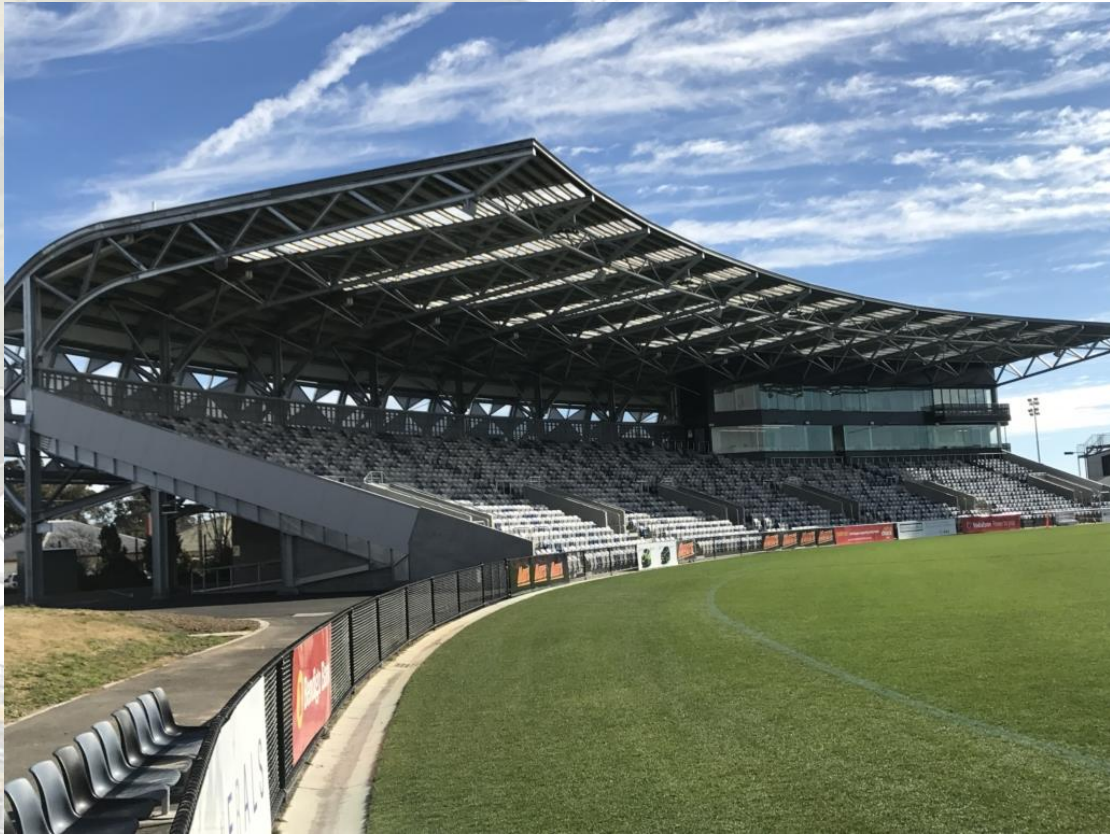
Εικόνα 21 Σύστημα προβόλου- Mars stadium- Πηγή: Kingsfield Galvanizing
