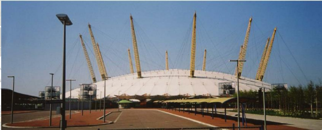
Εικόνα 25 Καλωδιωτό σύστημα- O2 Arena Stadium London-Πηγή: Research Gate,Wanda Jadwiga Lewis
