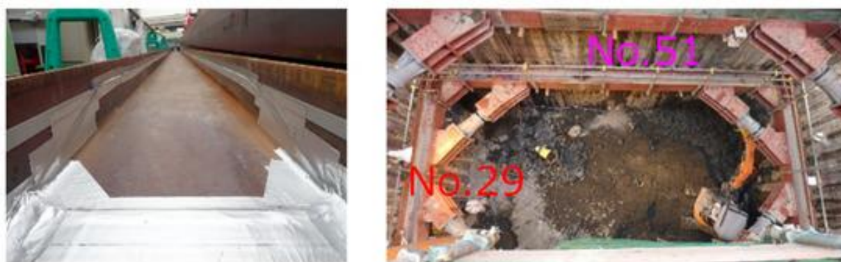
Εικόνα 33- Μετρήσεις μετατόπισης, εγκατεστημένη ίνα (αριστερά) και εργοτάξιο (δεξιά)
