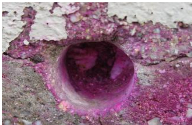
Εικόνα 19: Έλεγχος ενανθράκωση δοκιμίου σκυροδέματος, με χρήση διαλύματος φαινολοφθαλεΐνης, σε γέφυρα της Εγνατίας Οδού, (ΕΓΝΑΤΙΑ ΟΔΟΣ Α.Ε.)
