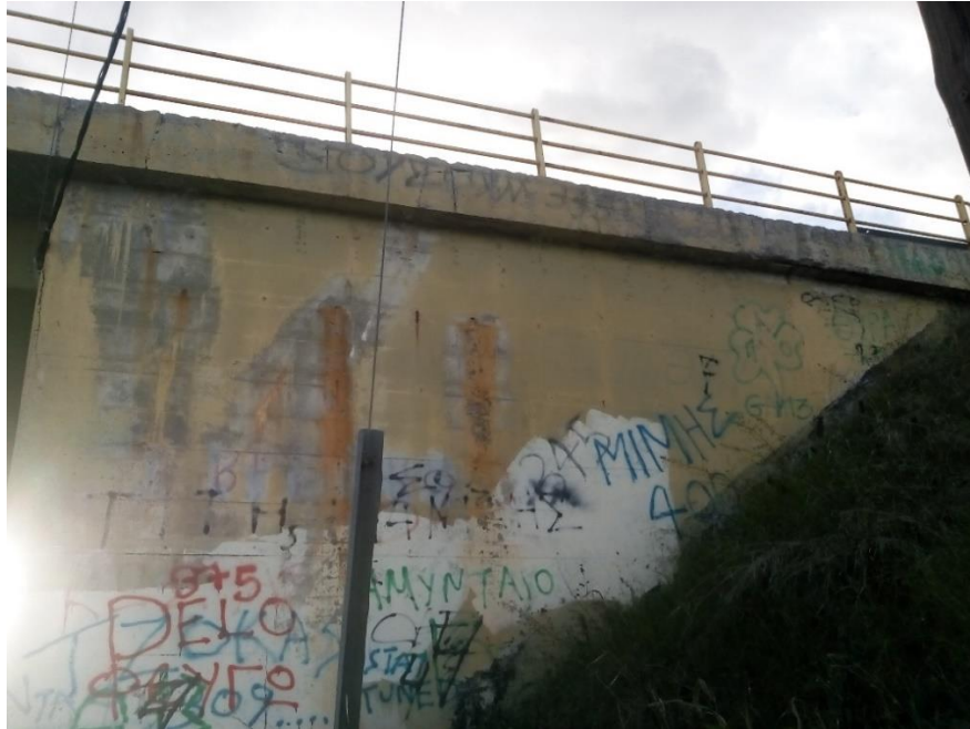
Εικόνα 79: Απεικόνιση των φθορών των πτερυγότοιχων της κάτω διάβασης ΚΔ.03.Ε.Ο.3.
