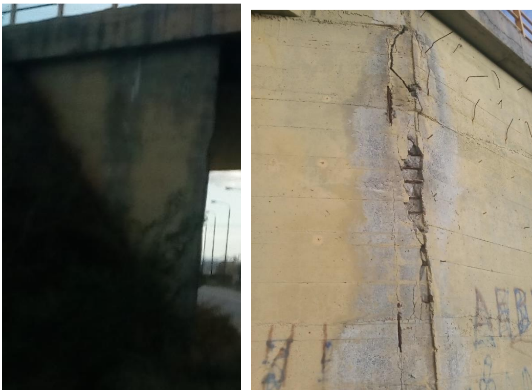
Εικόνα 88: Απεικόνιση των φθορών των πτερυγότοιχων της κάτω διάβασης ΚΔ.04.Ε.Ο.3.
