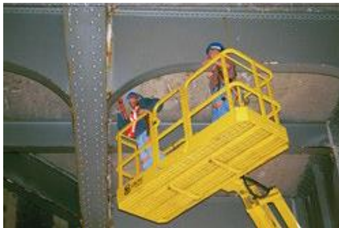
Εικόνα 4: Επιθεώρηση γέφυρας με τη χρήση καλαθοφόρου οχήματος, Πηγή: https://www.researchgate.net/publication , Πρόσβαση: 17-03-2022
