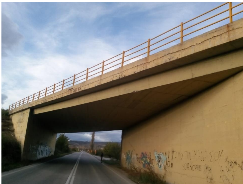
Εικόνα 81: Η βόρεια όψη της κάτω διάβασης ΚΔ.04.Ε.Ο.3.
