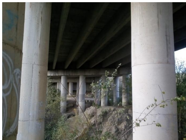
Εικόνα 28: Απεικόνιση των βάθρων του πρώτου ανοίγματος της γέφυρας ΓΕ.01.Ε.Ο.3.
