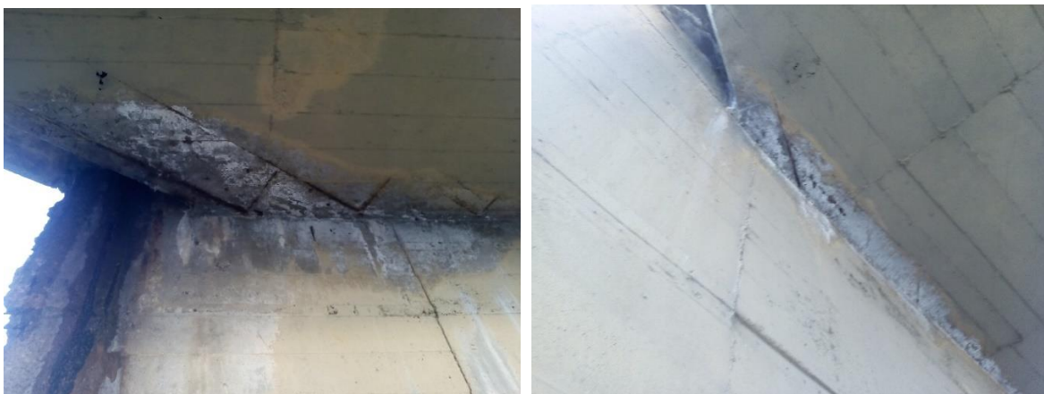
Εικόνα 84: Απεικόνιση των φθορών της κάτω παρειάς της πλάκας της κάτω διάβασης ΚΔ.04.Ε.Ο.3.
