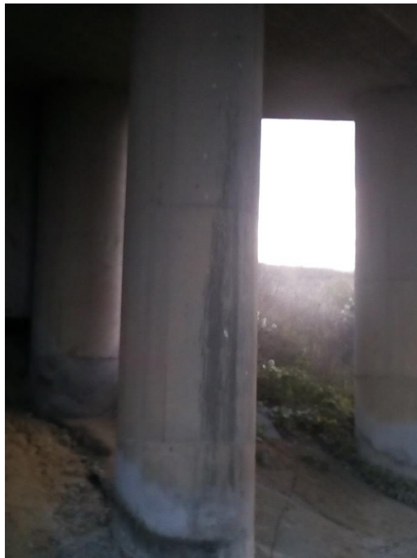
Εικόνα 57: Απεικόνιση των φθορών των ακροβάθρων της κάτω διάβασης ΚΔ.01.Ε.Ο.3.
