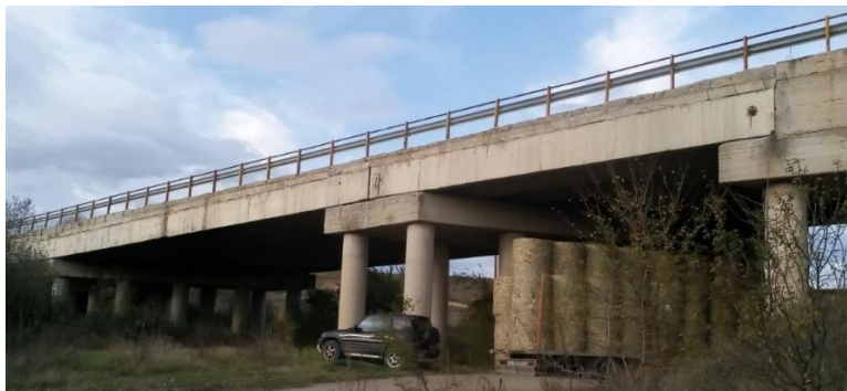
Εικόνα 27: Η δυτική όψη της γέφυρας ΓΕ.01.Ε.Ο.3.
