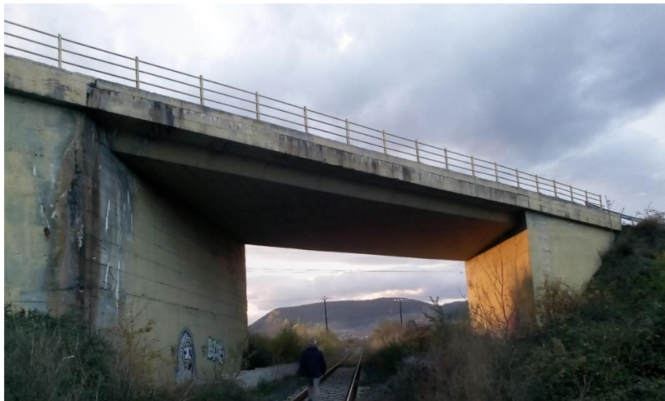
Εικόνα 35: Η δυτική όψη της γέφυρας ΓΕ.02.Ε.Ο.3.
