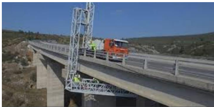
Εικόνα 3: Οπτική επιθεώρηση γέφυρας, Πηγή: https://google.com , Πρόσβαση: 01-02-2022
