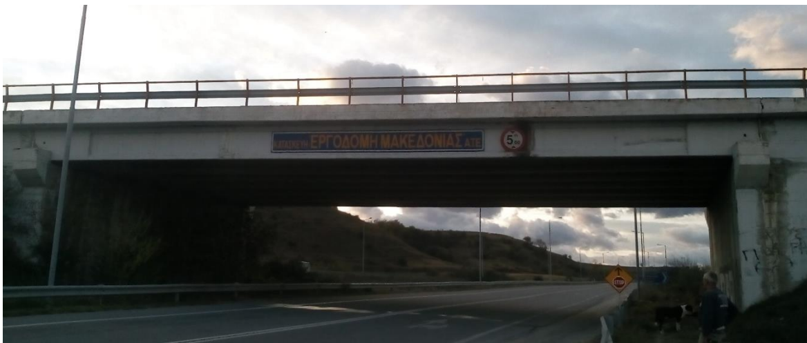
Εικόνα 45: Η ανατολική όψη της γέφυρας ΓΕ.03.Ε.Ο.3.
