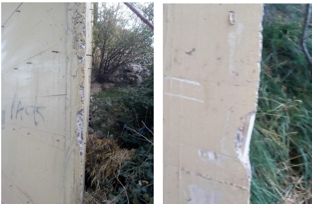
Εικόνα 67: Πλευρικές προσκρούσεις, με έκθεση σπλισμού, στα ακρόβαθρα της κάτω διάβασης ΚΔ.02.Ε.Ο.3.
