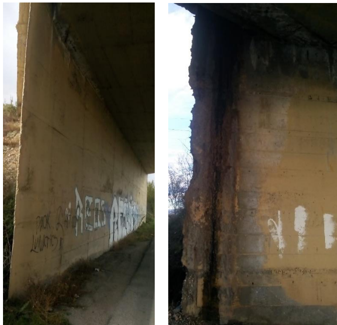
Εικόνα 83: Απεικόνιση των φθορών του νότιου και βόρειου ακροβάθρου αντίστοιχα της κάτω διάβασης ΚΔ.04.Ε.Ο.3.
