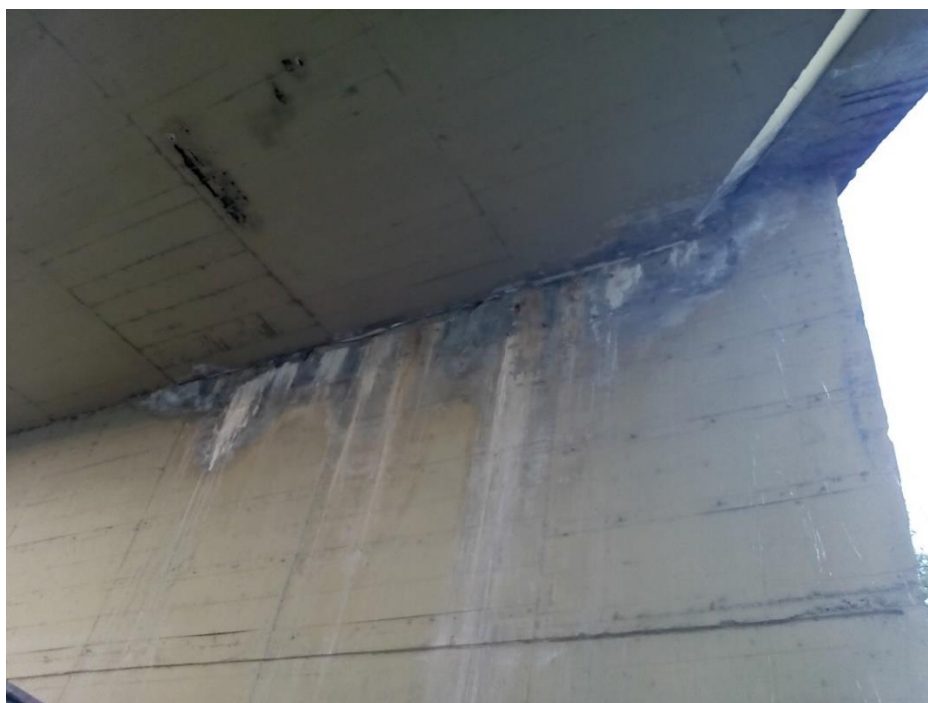
Εικόνα 66: Απεικόνιση των φθορών του δυτικού ακροβάθρου της κάτω διάβασης ΚΔ.02.Ε.Ο.3.
