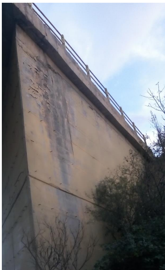
Εικόνα 72: Απεικόνιση των φθορών του δυτικού πτερυγότοιχου της κάτω διάβασης ΚΔ.02.Ε.Ο.3.
