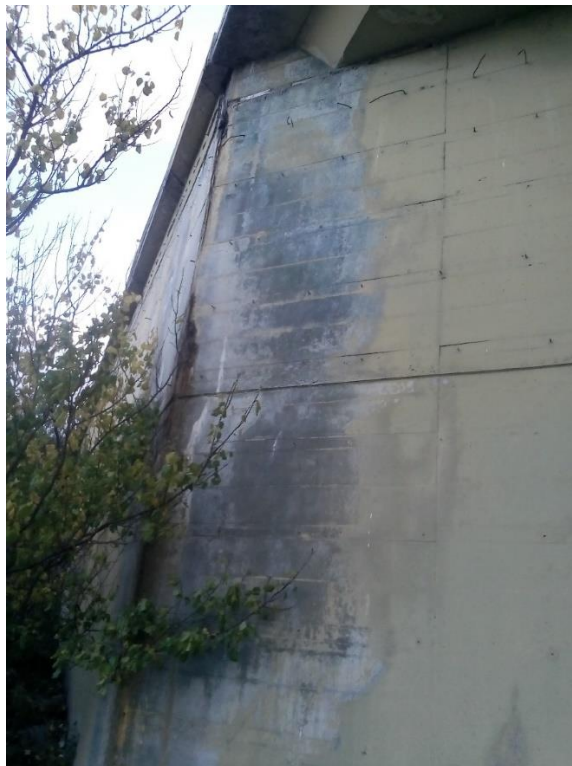
Εικόνα 65: Απεικόνιση των φθορών του ανατολικού ακροβάθρου της κάτω διάβασης ΚΔ.02.Ε.Ο.3.
