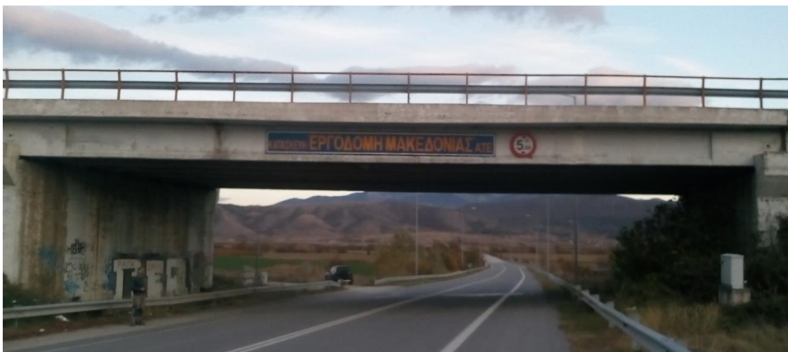
Εικόνα 46: Η δυτική όψη της γέφυρας ΓΕ.03.Ε.Ο.3.
