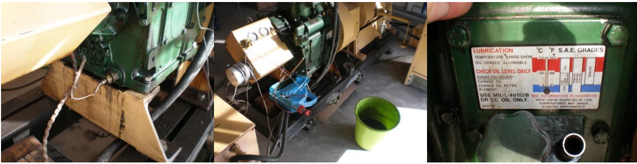
Εικόνα 5.1. Τάπα αφαίρεσης λιπαντικού λαδιού κινητήρα (αριστερά), μέσα συλλογής λιπαντικού λαδιού (κέντρο) και ταμπελάκι τεχνικών προδιαγραφών λιπαντικού λαδιού και οδηγίες συχνότητας αλλαγής λαδιού και φίλτρου λαδιού (δεξιά).
