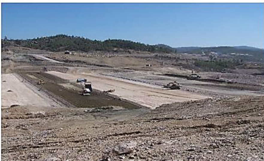
Εικόνα 4.8 Ζώνες φίλτρων – στραγγιστηρίων (ΑΕΓΕΚ, 2001)
