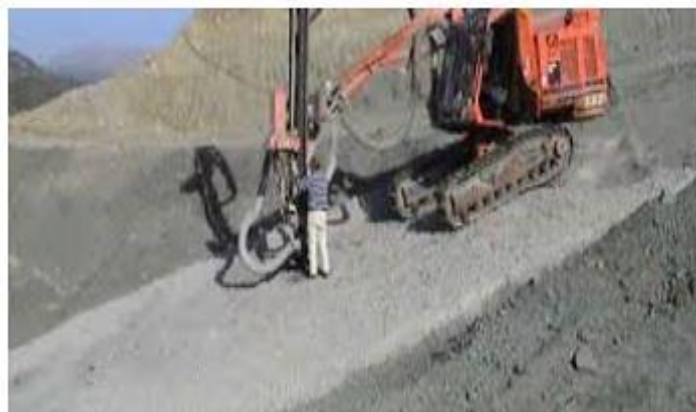
Εικόνα 4.6 Τσιμεντενέσεις τάπητα (ΑΕΓΕΚ, 2001)
