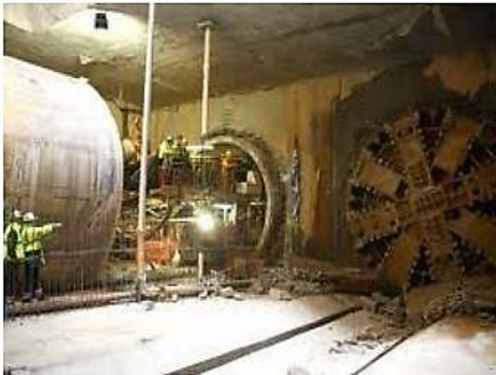
Εικόνα 4.3 Εκσκαφή σήραγγας εκτροπής
