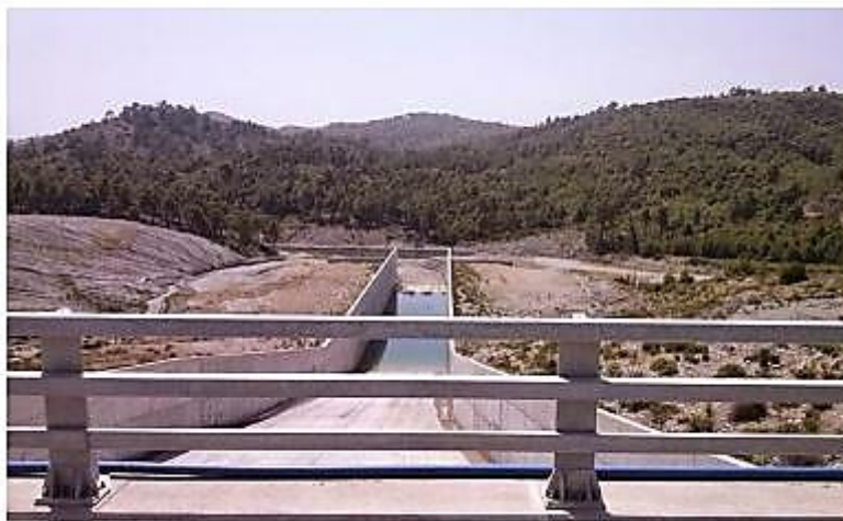
Εικόνα 4.11 Σύστημα υπερχείλισης (ΑΕΓΕΚ, 2001)
