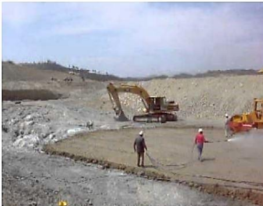
Εικόνα 4.10 Κατασκευή Αυχενικού φράγματος (ΑΕΓΕΚ, 2001)
