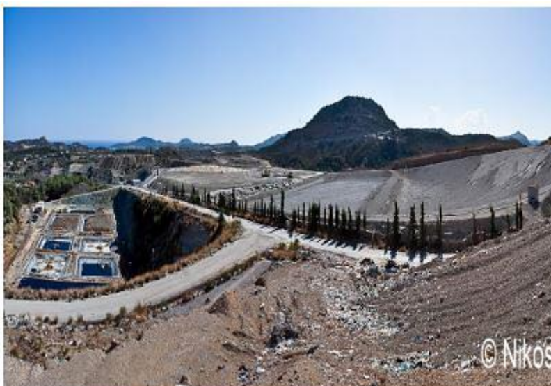
Εικόνα 4.7 Γενική όψη φράγματος κατά την κατασκευή (ΑΕΓΕΚ, 2001)
