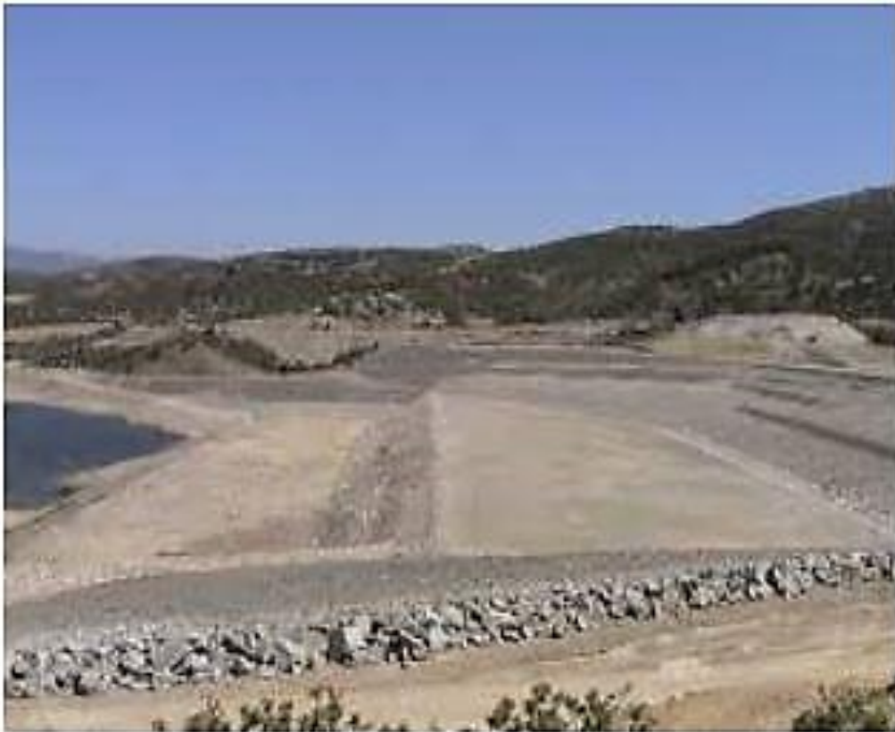
Εικόνα 4.5 Βοηθητικό – Κύριο άναντη πρόφραγμα
