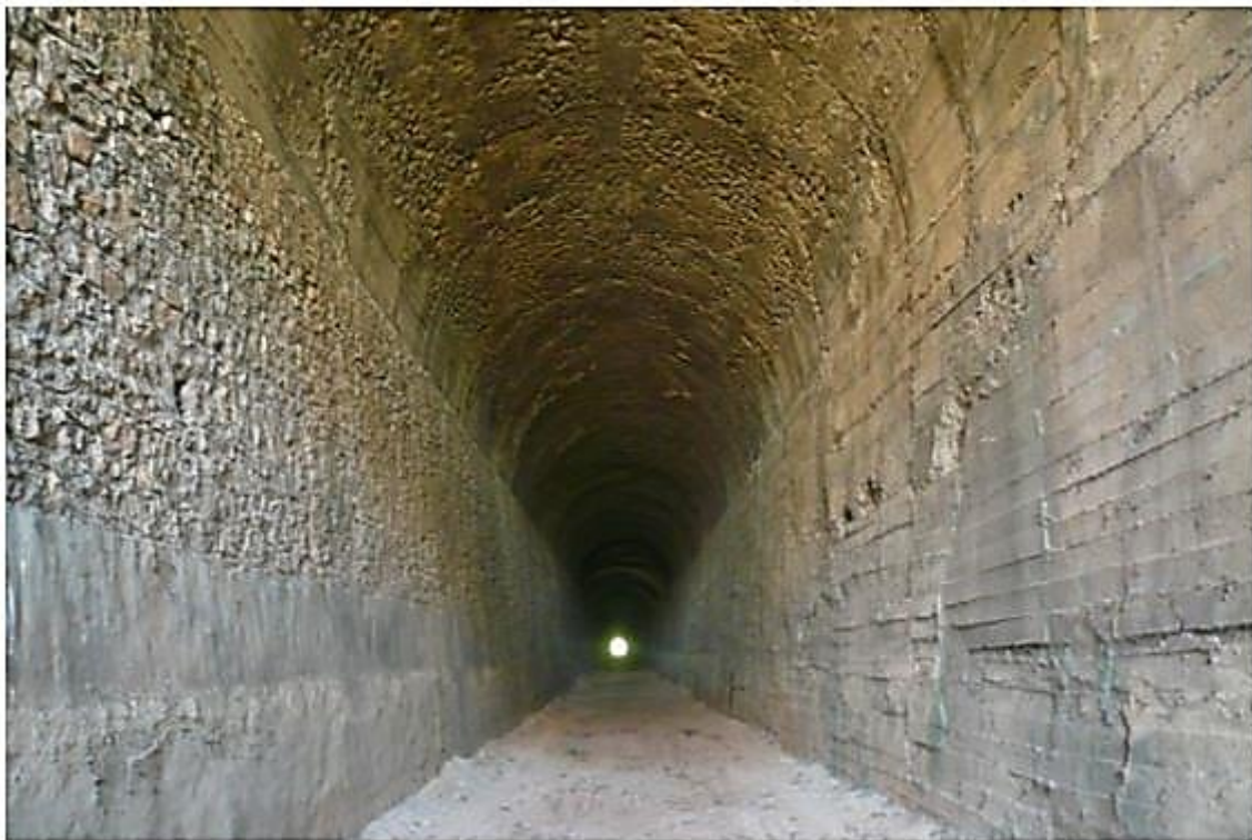
Εικόνα 4.12 Αποστραγγιστική σήραγγα (ΑΕΓΕΚ, 2001)
