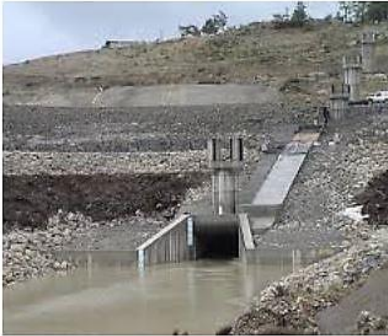
Εικόνα 4.2 Είσοδος σήραγγας εκτροπής
