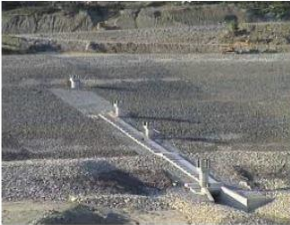
Εικόνα 4.4 Στόμιο εκκένωσης και υδροληψίας
