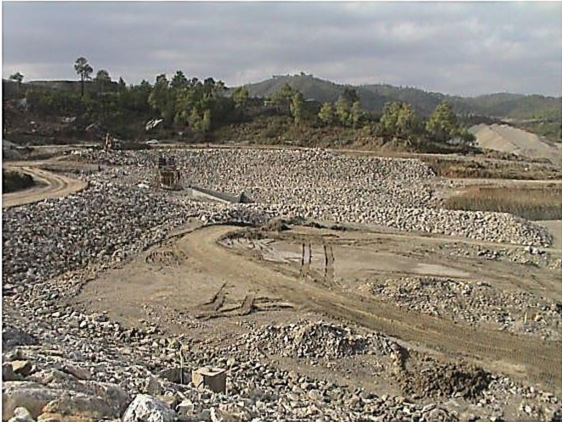
Εικόνα 4.9 Λιθορριπή προστασίας (ΑΕΓΕΚ, 2001)
