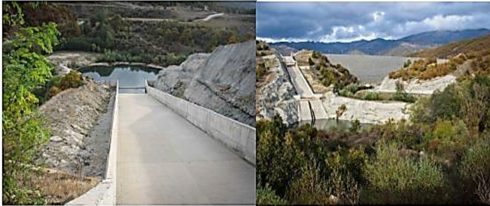
Εικόνα 5.1 Υπερχειλιστής τύπου Ogee (ΕΕΝ ΓΑΔΟΥΡΑ)
