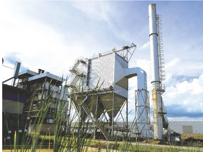
Εικόνα 2.15: Ηλεκτροστατικό Φίλτρο
