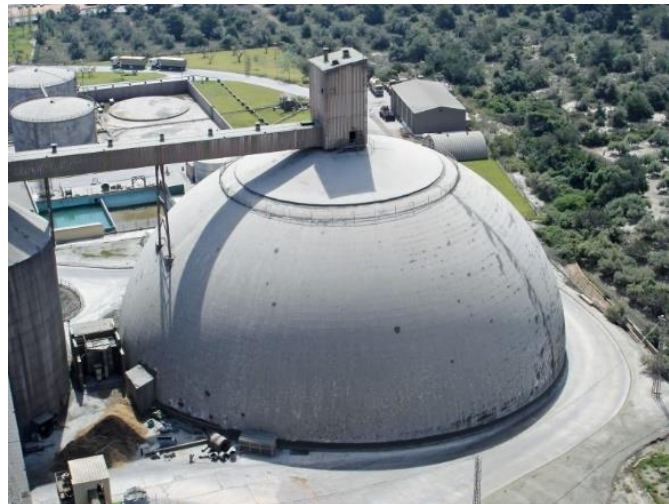
Εικόνα 1.7: Αποθήκευση Κλίνκερ
