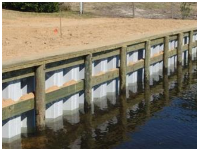
Εικόνα 50. Κρηπιδότοιχος ( http://bulkheadbuilders.com/bulkheads-and-retaining-wall-construction/ )
