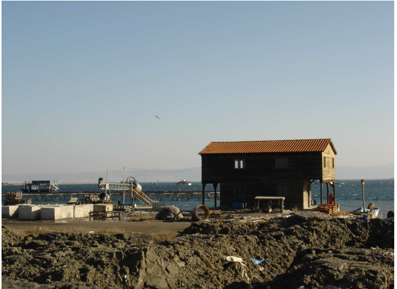
Εικόνα 4.2. Παράκτια ζώνη στη Χαλάστρα Θεσσαλονίκης, όπου φαίνεται το σπιτάκι, το τούνελ που γίνεται πλύσιμο και η φόρτωση των μυδιών καθώς και σκάφη μυδοκαλλιέργειας.
