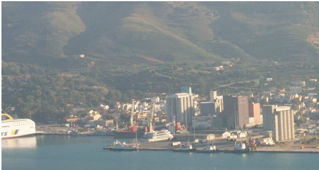
Εικόνα 2.1: Εκφόρτωση πλοίου στις εγκαταστάσεις της εταιρίας Μύλοι Κρήτης και της Κεντρικής Ένωσης Χανίων στο λιμάνι της Σούδας.
