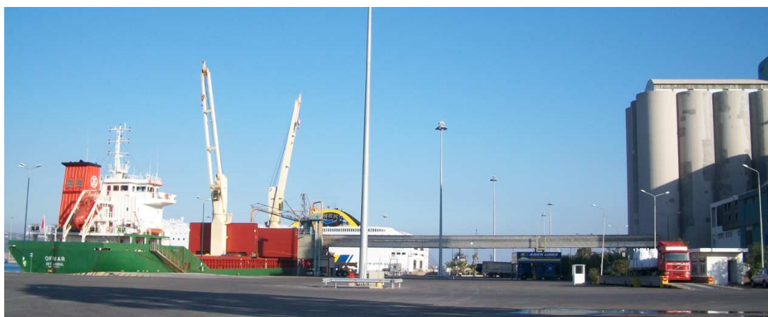
Εικόνα 3.1: Προμήθεια χύδην φορτίου από εξοπλισμό άμεσα συνδεδεμένο με το κτίριο των σιλω της Μύλοι Κρήτης Α.Ε.
