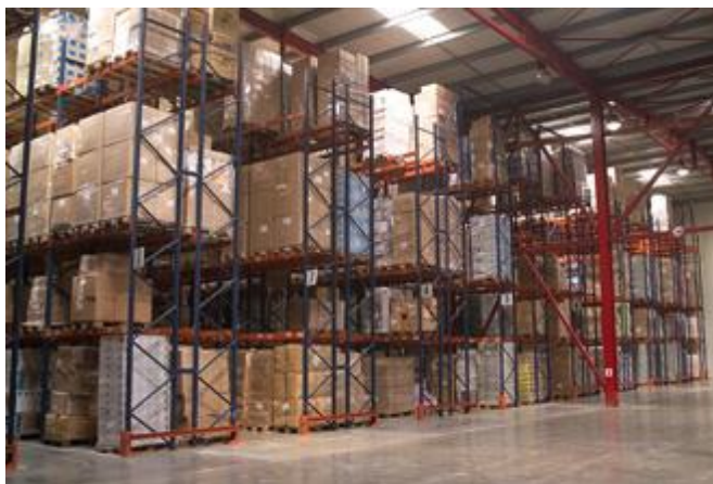
Φωτογραφία 3.11: Εγκαταστάσεις αποθήκης
