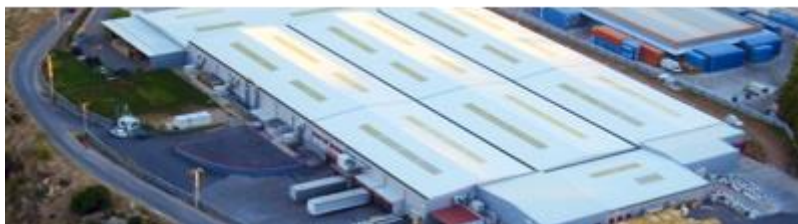
Φωτογραφία 3.20: εγκαταστάσεις του Ασπρόπυργου – Κύριλλος.
