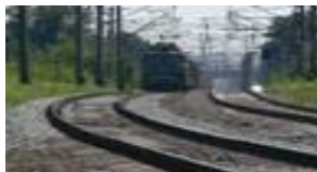
Φωτογραφία 3.7: Σιδηροδρομικές εγκαταστάσεις.
