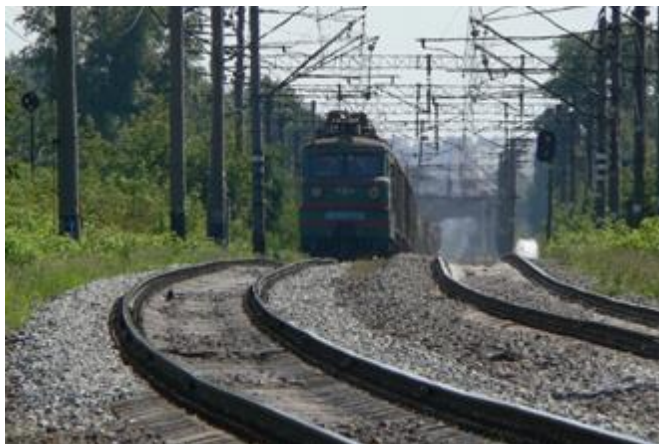
Φωτογραφία 3.18: Σιδηροδρομικές εγκαταστάσεις.
