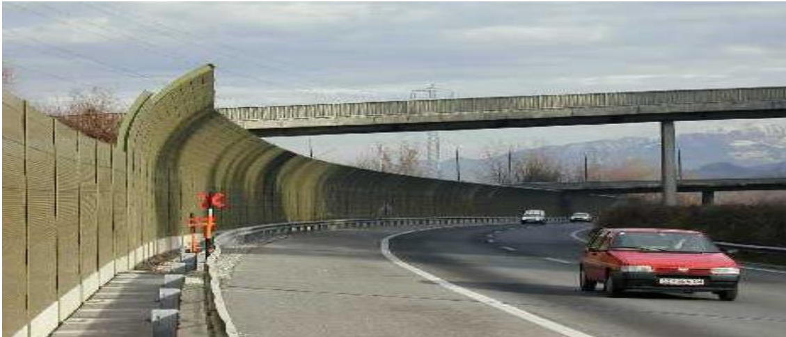
Εικόνα 4. Τείχος προστασίας θορύβου σε αυτοκινητόδρομο στην Αυστρία. Πηγή : http://www.tirol.gv.at/uploads/pics/abb004wiesengasse3.jpg
